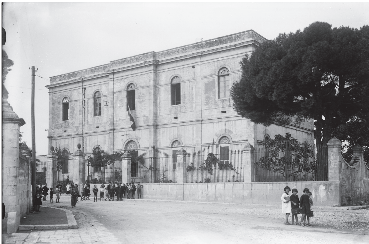
Fig. 1. Cassano delle Murge: edificio scolastico, ex ospedale Conte di Torino
