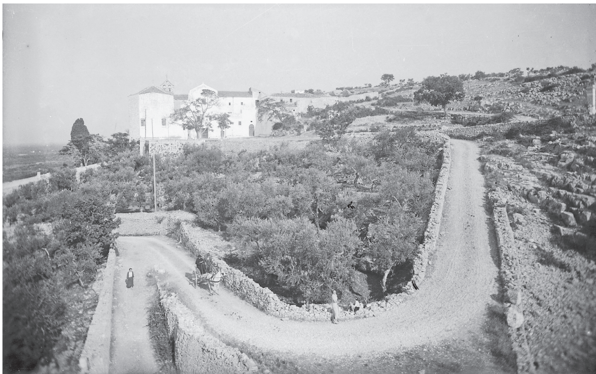
Fig. 2. Cassano delle Murge: strada di accesso non asfaltata al convento di Santa Maria degli Angeli, anni Trenta
