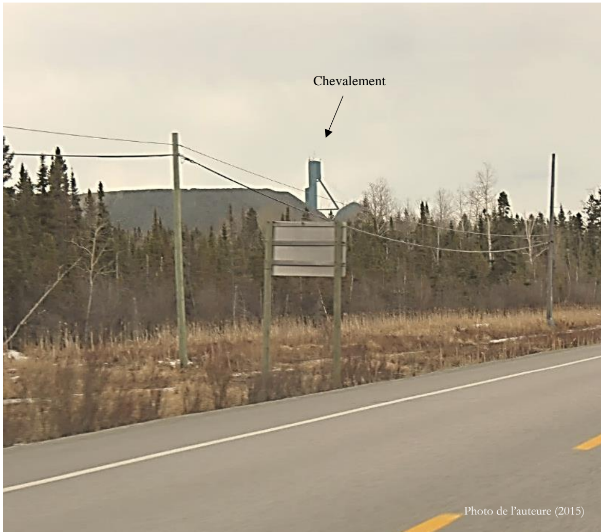
Photo 19 Chevalement de la mine Lapa vu de la route 117 entre Rouyn-Noranda et Rivière-Héva
