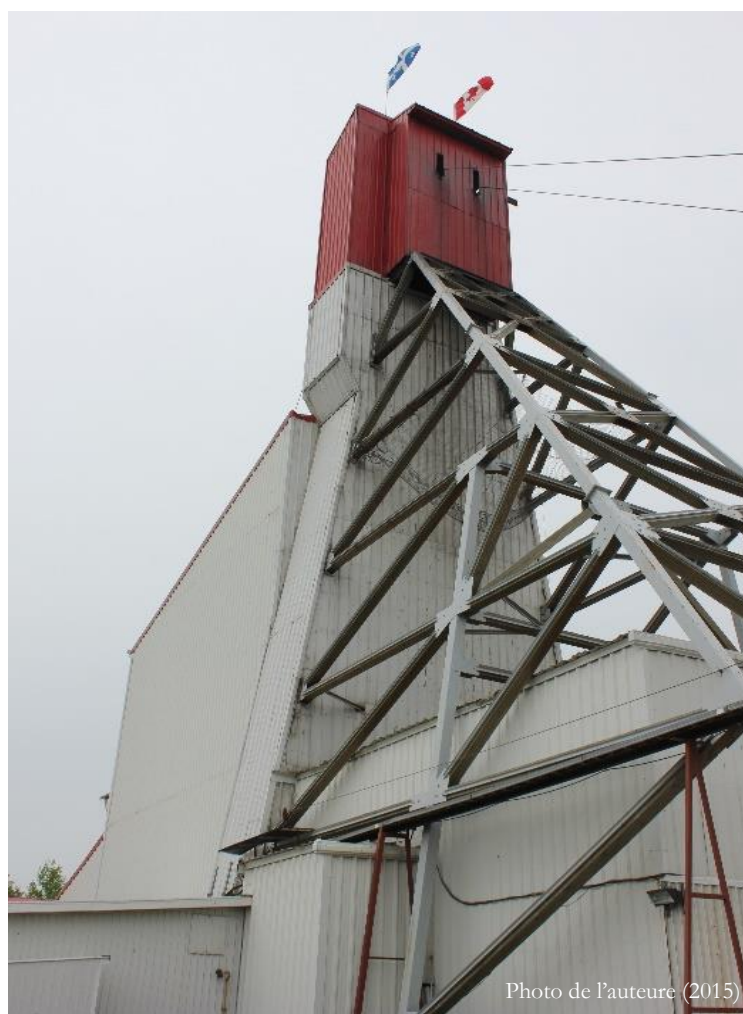
Photo 9 Chevalement de la mine Beaufor
