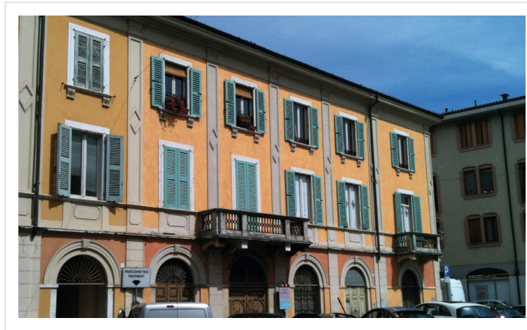
Kuva 121. Parvekkeet ja terassit sekä erilaiset katokset etäännyttävät valoa tuoden varjoillaan suojaa. Auringonvalon pääsy sisätiloihin voidaan säätää myös ikkunoiden eteen asetetuilla aurinkosuoja-ja.
