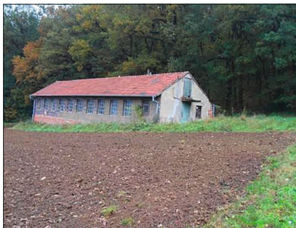
Obr. 10: Zanedbané místo. Zdroj: archiv L. Peřinové.
