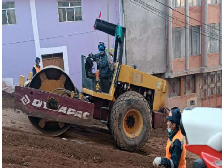
Figura 10. Movimiento de Tierra en subrasante
