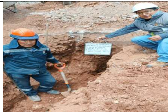
Imagen 04: Sondeo de la calicata N°1
