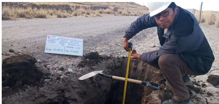
Figura 27. Extracción de muestras de las calicatas C-1, C-2, C-3 y C-4.
