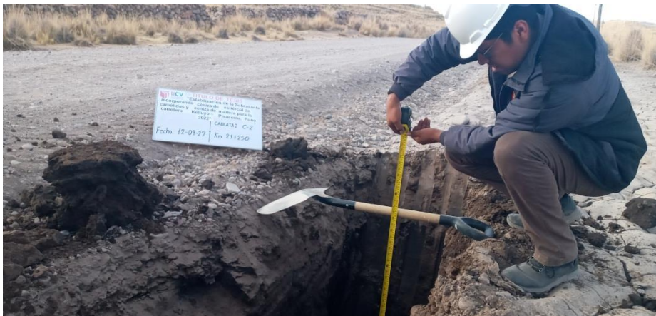
Figura 24. Profundidad de las calicatas.
