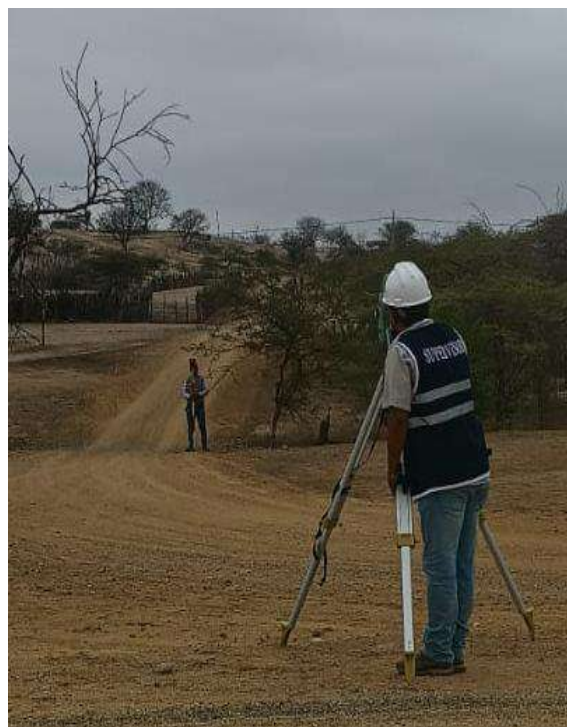
Foto N° 05: Realizando del levantamiento topográfico en la vía El Tubo-Pedregal
