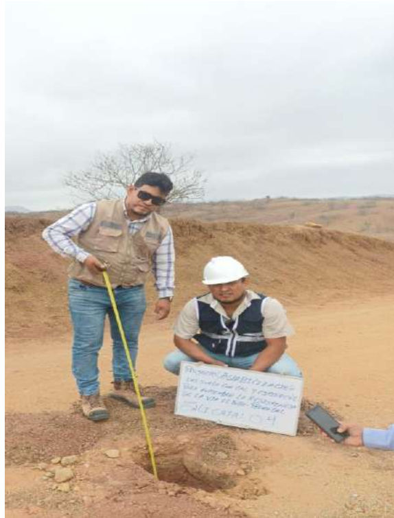
Foto N° 10: Excavación de la C-4
