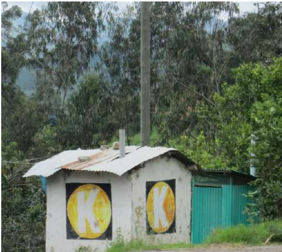
Vista: Letrina existente
