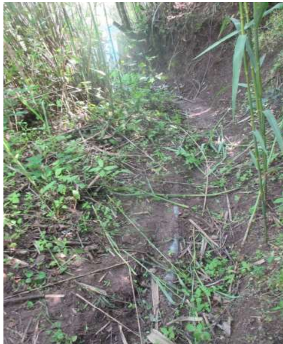
Vista: tubería de conducción expuesta
