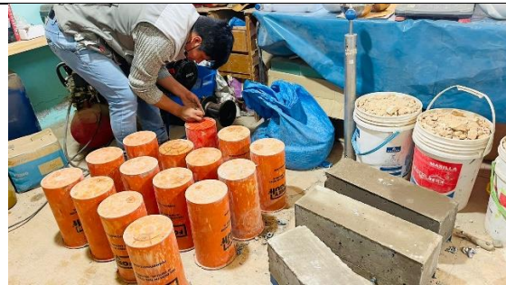
Figura 5. Moldeo de prismas de concreto.
