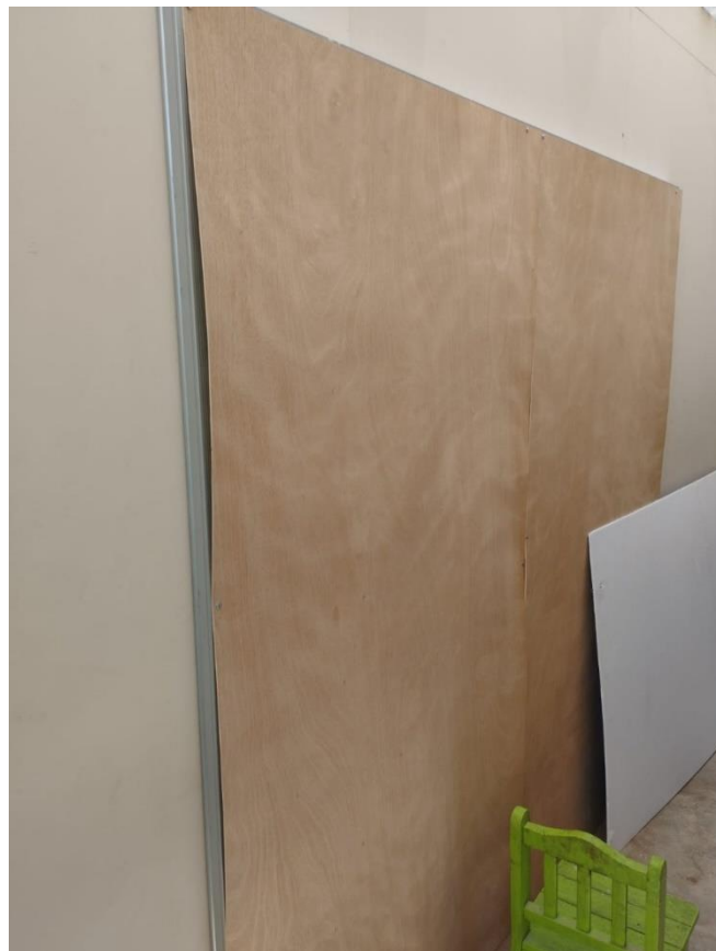
Foto 2: Instalación de paneles de triplay y PVC
