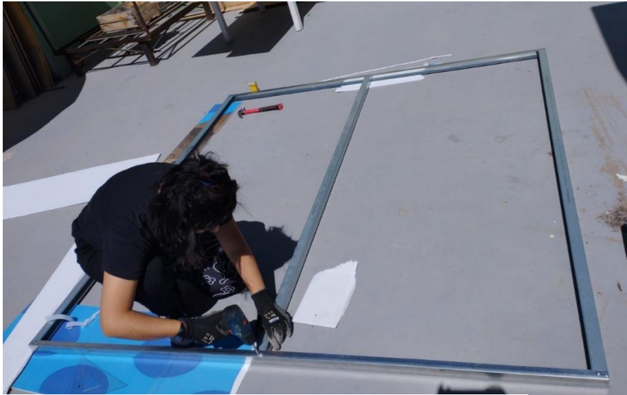
Foto 1: Construcción de la estructura metálica
