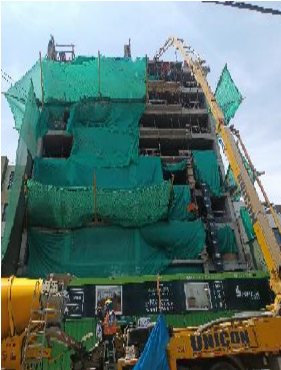
Figura N° 3: Vista Frontal de la Obra Wagner
