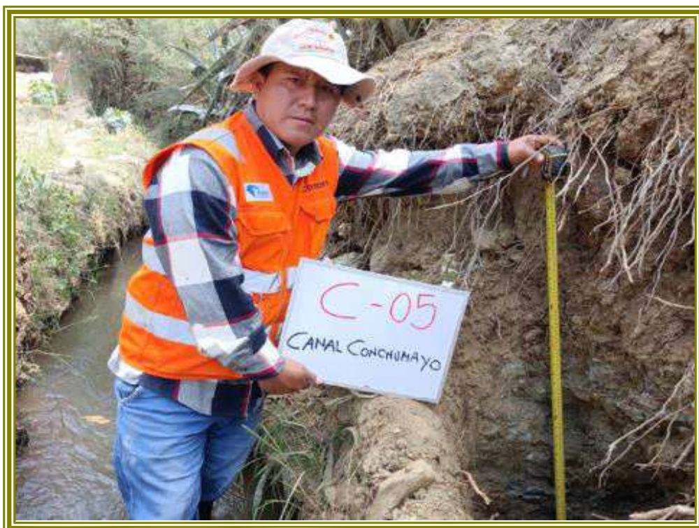
VISTA FOTOGRAFICA DE LA CALIGATA N° 05
