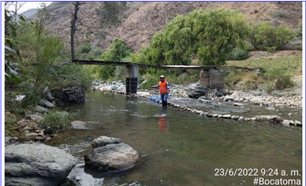
Foto N° 03: En la imagen se observa el punto de la bocatoma, donde se plantea deriva una demanda hídrica de 0.048 m 3 /s.
