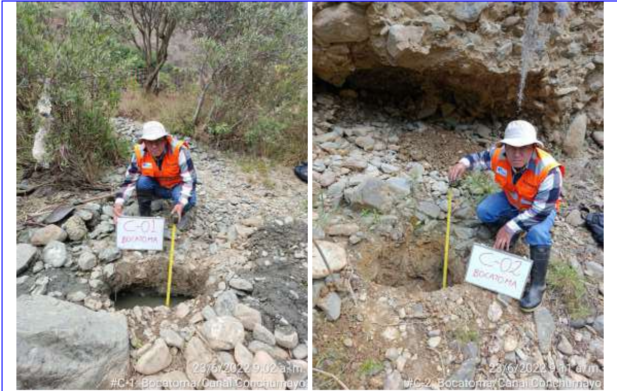
Foto N° 07: En las imágenes tanto izquierda como derecha se observan las calicatas 1 y 2 tomados en la bocatoma.
