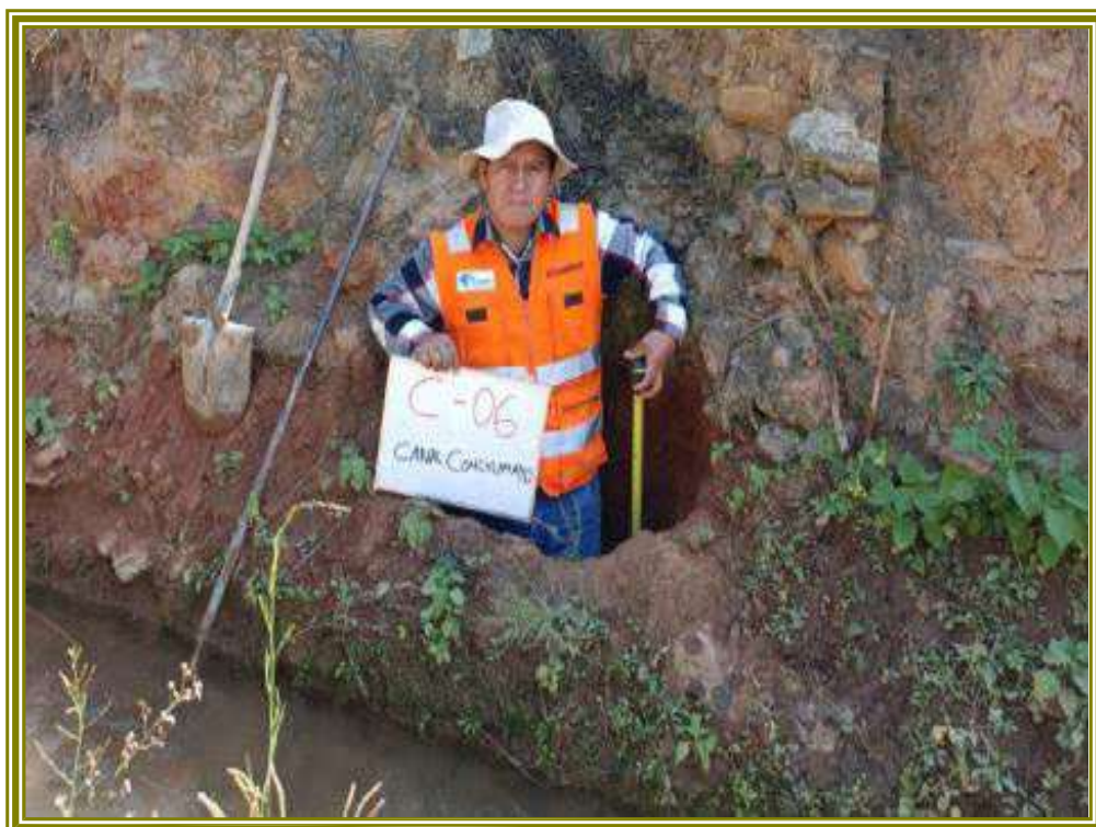
VISTA FOTOGRAFICA DE LA CALIGATA N° 06
