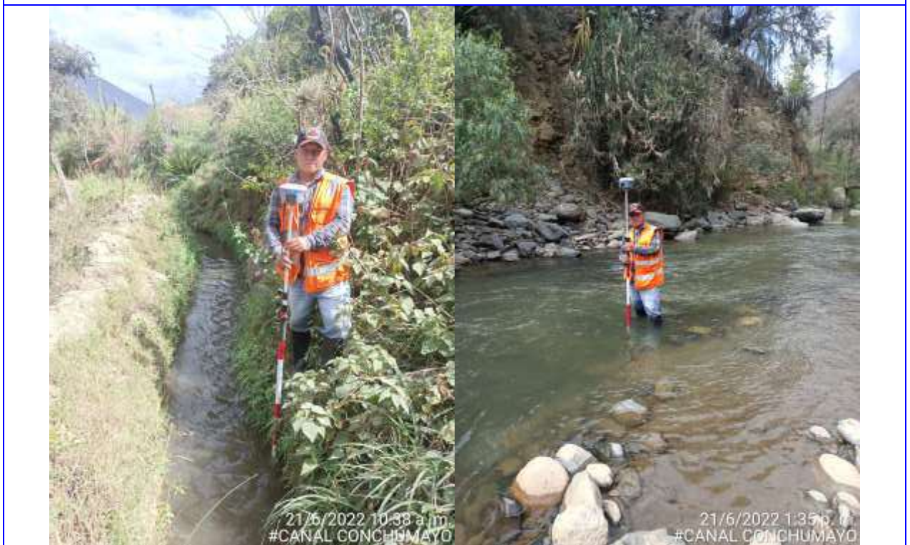
Foto N° 06: En la imagen izquierda se observa registrando los puntos topográficos del canal, y en la imagen derecha se muestra tomando los puntos topográficos del área de la bocatoma.
