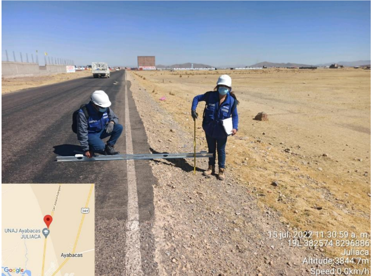
Figura N° 13: Representación gráfica de la falla de “ DESNIVEL CALZADA-BERMA ”
