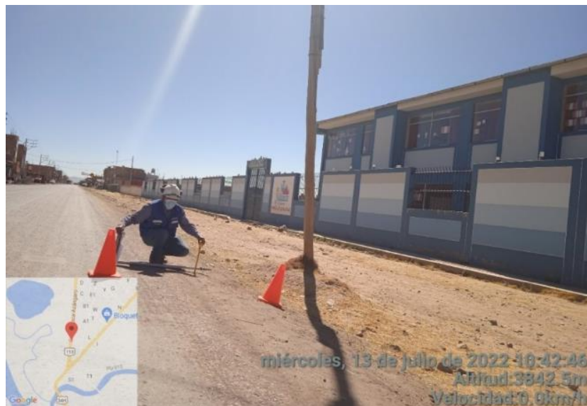
Figura N° 32: Representación gráfica de la falla de “DESNIVEL CARRIL/BERMA”
