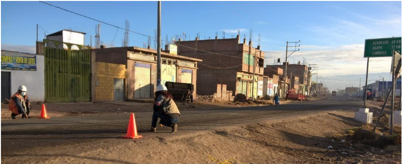
Figura N° 65: Representación gráfica de la medición de la calzada 6.20 metros Fuente: Elaboración nuestra
