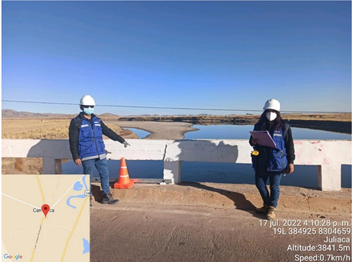
Figura N° 29: Representación gráfica de la falla de “ ESTRUCTURAS VIALES (carácter: puentes) ” Fuente: Elaboración nuestra
