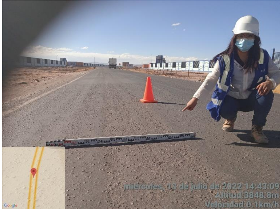
Figura N° 34: Representación gráfica de la falla de “ ABULTAMIENTOS Y HUNDIMIENTOS ” Fuente: Elaboración nuestra
