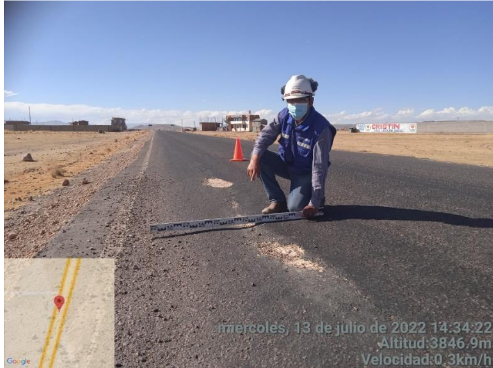
Figura N° 33: Representación gráfica de la falla de “HUECOS” Fuente: Elaboración nuestra
