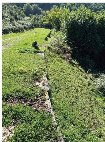
Figura 2. Muros de sostenimiento y piedras guardarruedas en el Camino Real (MRB).
