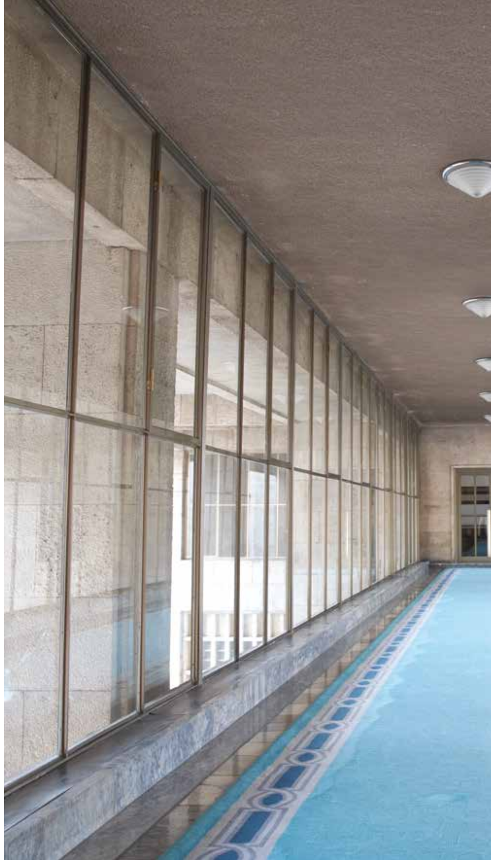
Tören Salonu ile Ana Bina arasındaki Geçit
