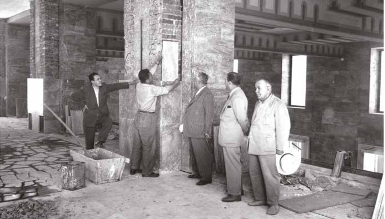
TBMM inşaatı, Şeref Holü Galerisi, 1950'ler Ziya Payzın Arşivi
