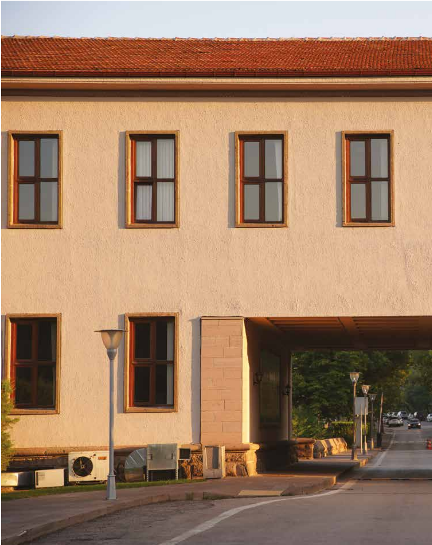
Muhafız Taburu Binası, Geçit
