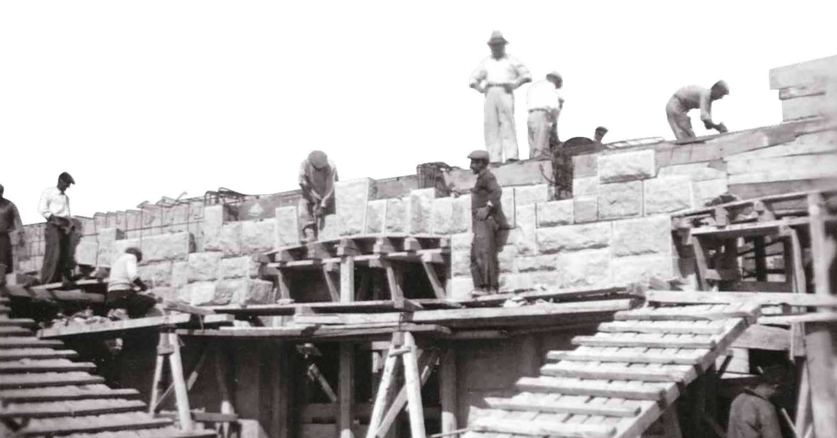
TBMM inşaatı Ziya Payzın Arşivi
