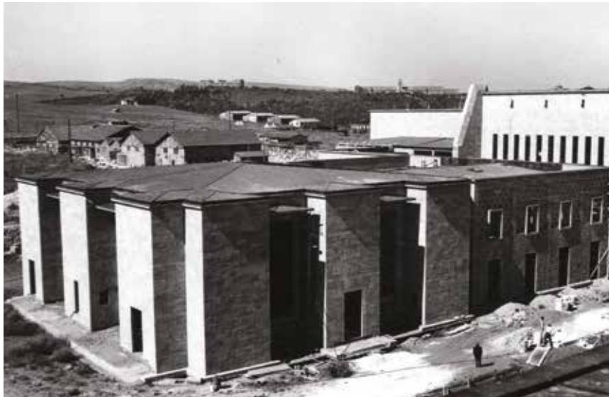
TBMM inşaatı Parti Grup Toplantı Salonları Ziya Payzın Arşivi
