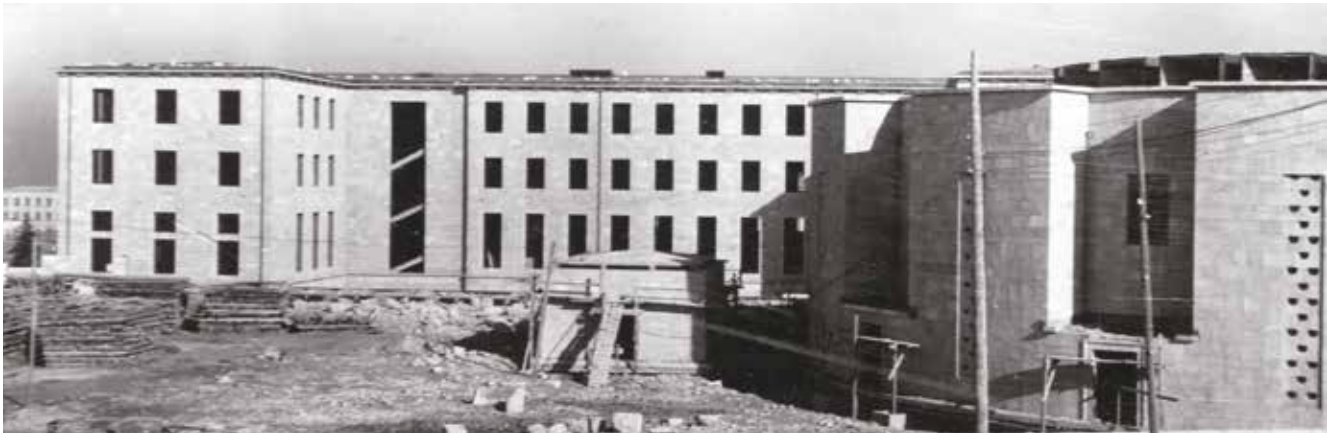
TBMM inşaatı, güney cephe Ziya Payzın Arşivi
