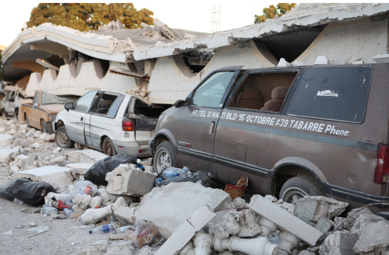
Vehículos aplastados como consecuencia del terremoto que sacudió a Haití el 12 de enero de 2010. Fuente: https://www.usgs.gov/
