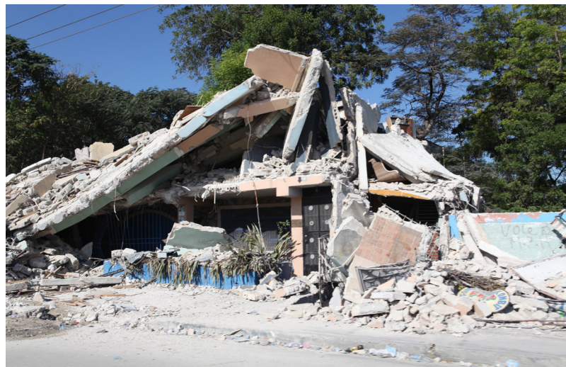
Edificación colapsada en el terremoto de Haití. Fuente: https://www.usgs.gov/
