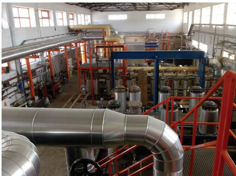
Rycina 44. Widok na halę Geotermii Stargard (fot. B. Igliński)
