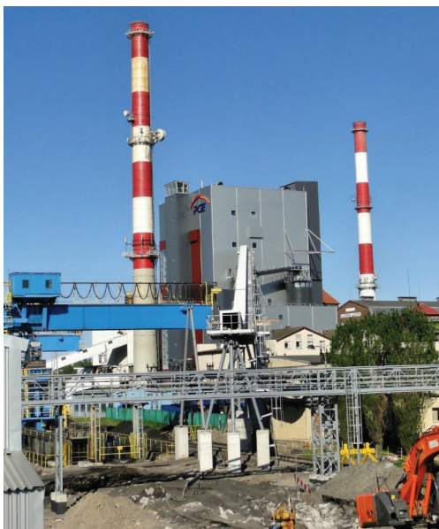
Rycina 7. Kocioł na biomasę (w głębi, między kominami) Elektrowni Szczecin (fot. Kapitel) [19]
