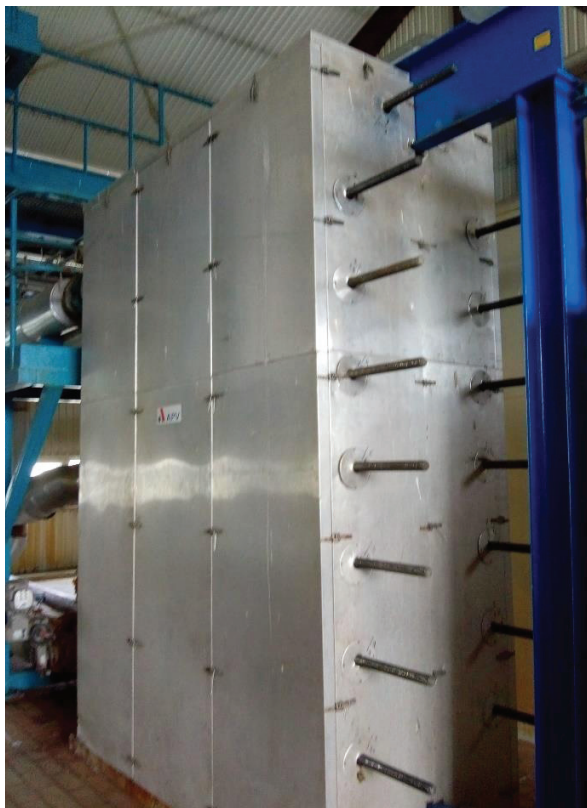
Rycina 43. Płaskie wymienniki ciepła w Geotermii Pyrzyce (fot. B. Igliński)
