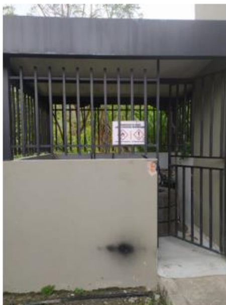
Cuarto de almacenamiento temporal.
