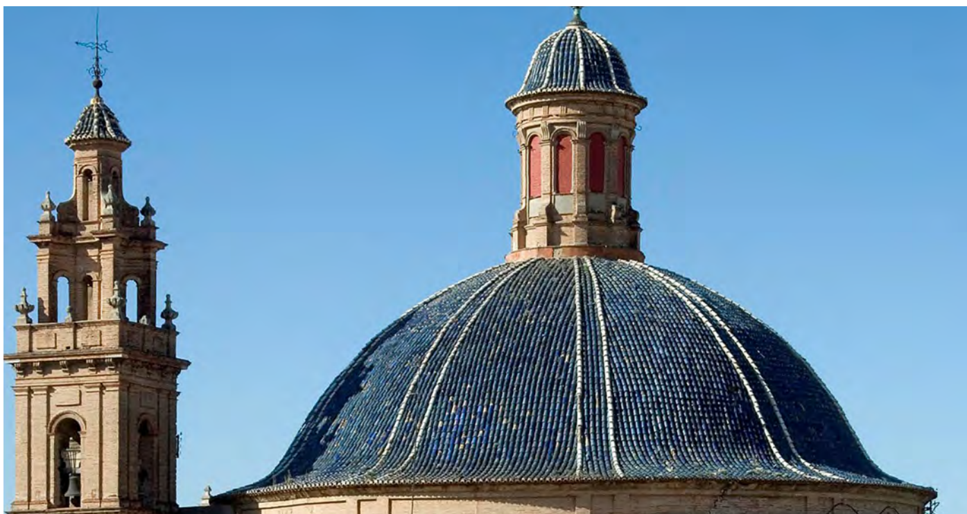
Exterior de la cúpula / Exterior of the dome
