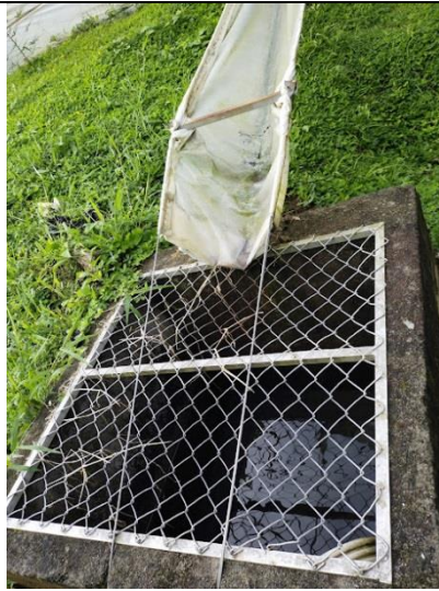
Primer tanque sedimentador
