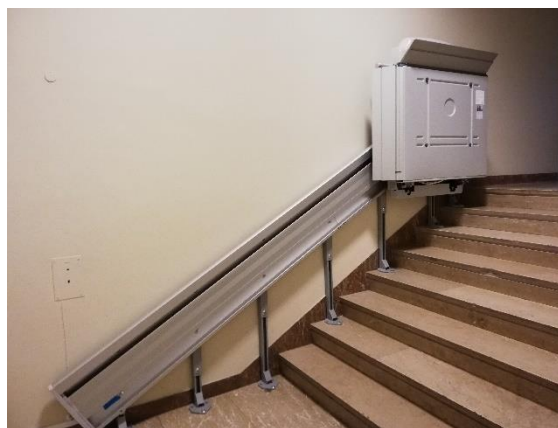
Figura 40 - Acessibilidades no interior do Edifício
