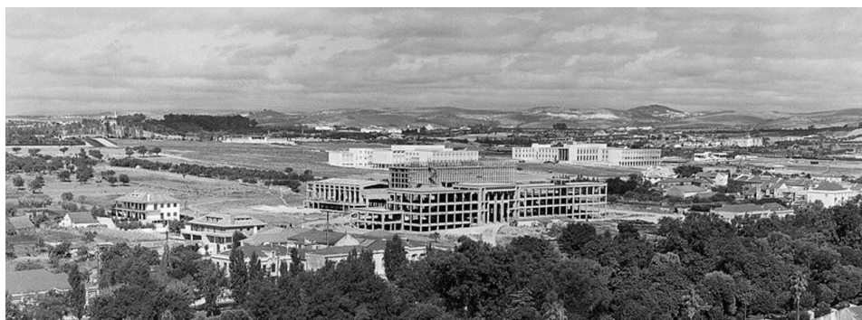
Figura 25 - Vista geral com estrutura parcialmente construída. Foto do arquivo do Forte de Sacavém do SIPA (IHRU)
