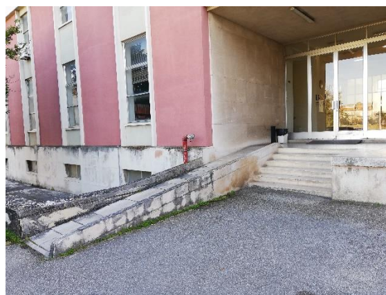
Figura 38 Acessibilidades na Porta de Serviço
