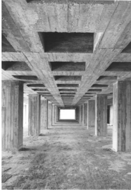
Figura 26 - Transição da estrutura da torre para a estrutura da base. Foto do arquivo do Forte de Sacavém do SIPA (IHRU).
