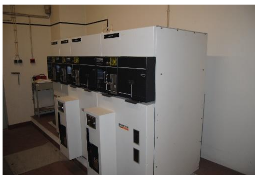
Figura 76 – Inversor do PT
