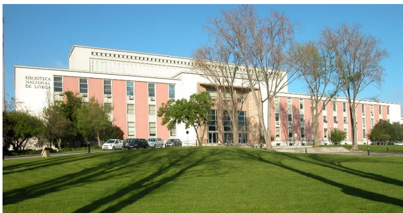
Figura 17 – Edifício da Biblioteca Nacional [BNP - 2017]
