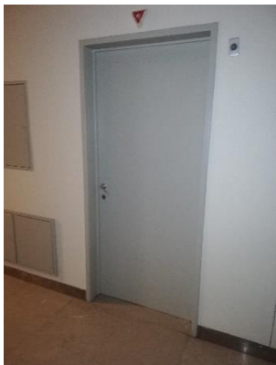
Figura 59 – Portas Interiores de Gabinetes
