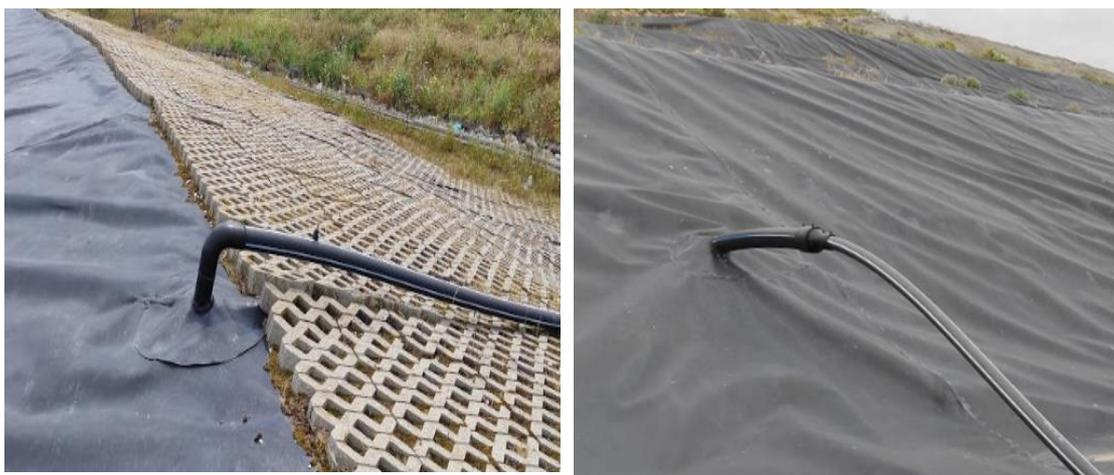
Figura 2. 16 - Dreno vertical com acessório de tubagem curvo e dreno horizontal . (Foto do autor).
