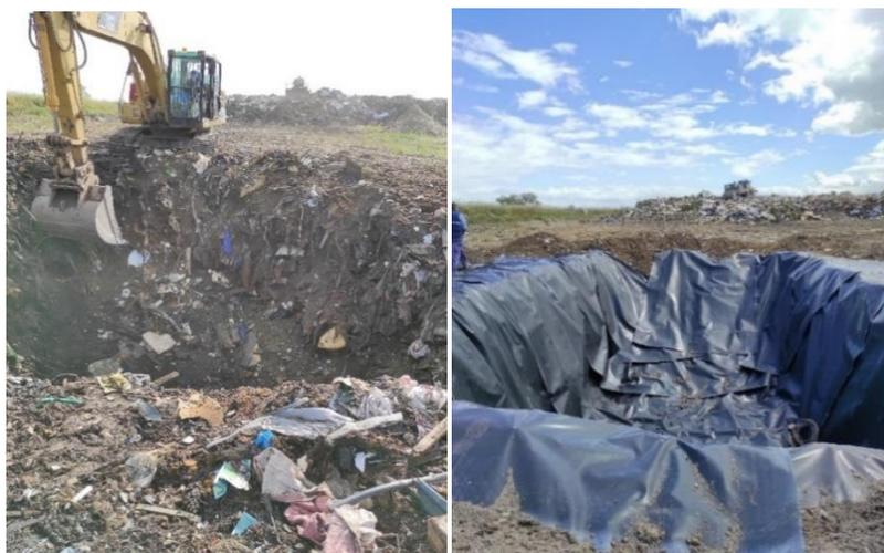
Figura 3. 21 - Escavação e início da colocação do sistema de impermeabilização do biorreator. (Foto do autor)
