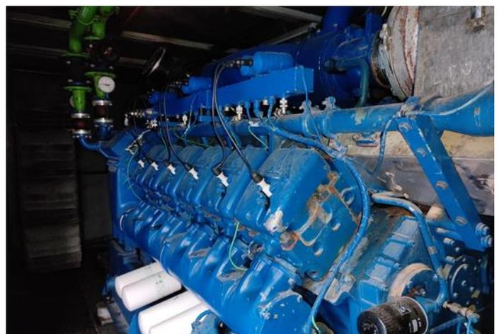
Figura 2. 19 - Motor de Biogás (Foto do autor)
