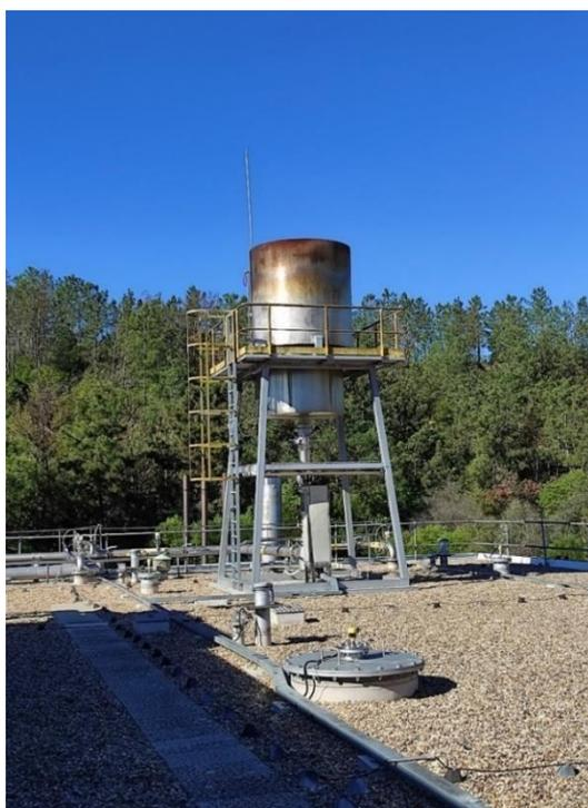
Figura 3. 16 - Queimador de Emergência do digestor anaeróbio.
