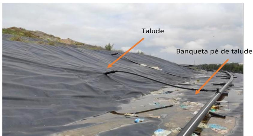
Figura 2. 15 - Talude e banquetta de pé de talude da célula D do Ecoparque do Seixal. (Foto do autor).
