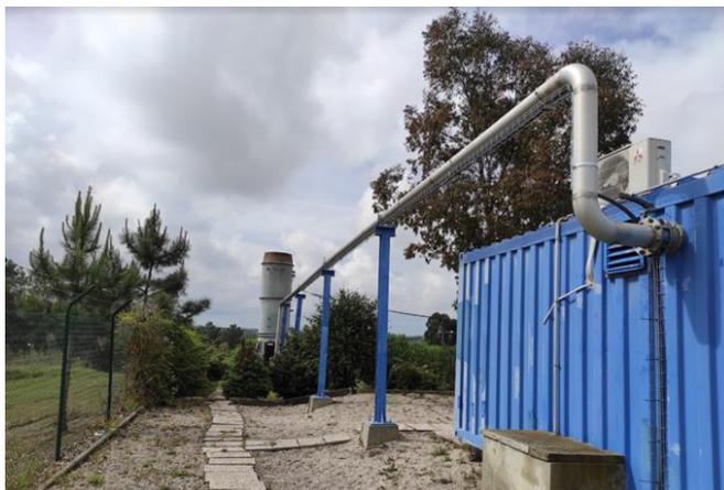
Figura 2. 20 - Circuito de emergência para a queima de biogás. (Foto do autor).
