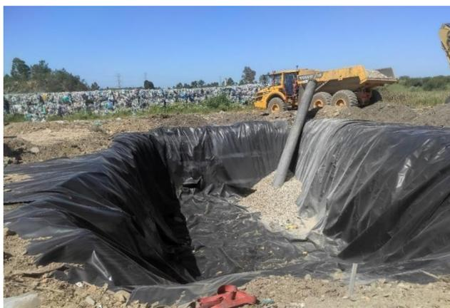
Figura 3. 22 - Sistema de drenagem de lixiviados e camada drenante no início da execução (Foto do autor)
