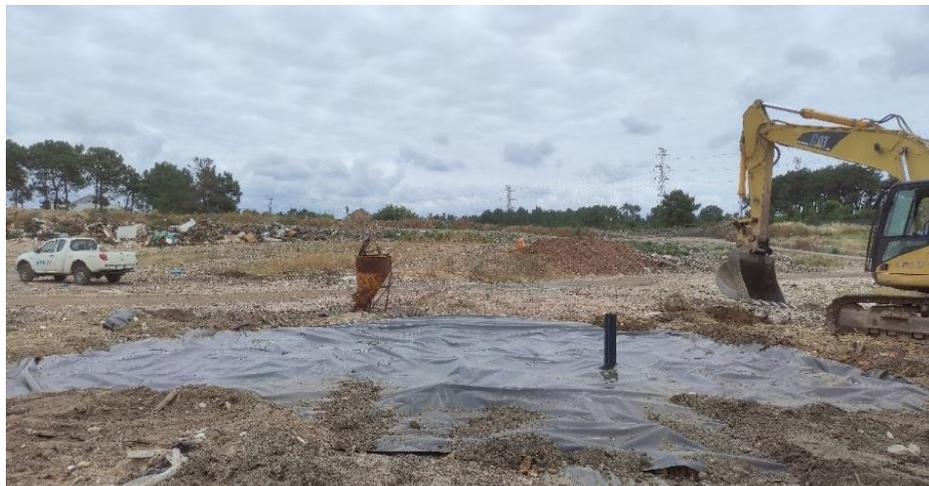
Figura 3. 25 - Colocação da geomembrana seguida da deposição das terras de cobertura. (Foto do autor)
