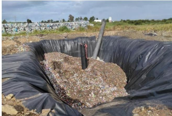
Figura 3. 23 - Dreno de biogás envolvido pelo tubo guia, dentro da massa de resíduos. (Foto do autor)
