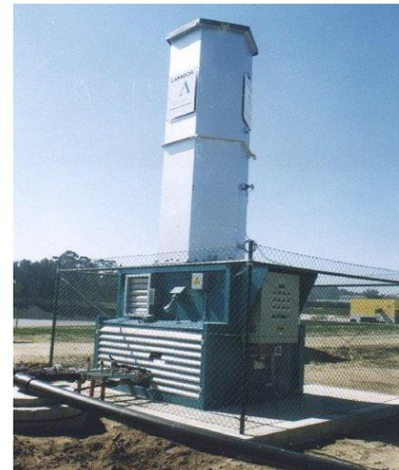
Figura 2. 18 - Queimador do biogás gerado, do biogás excedente de aproveitamento ou como emergência
