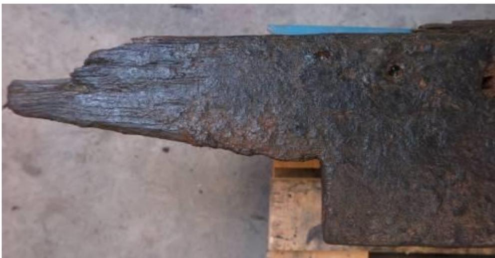
**Figura 142** – Escarva existente numa das extremidades da peça EDP\_0475.
