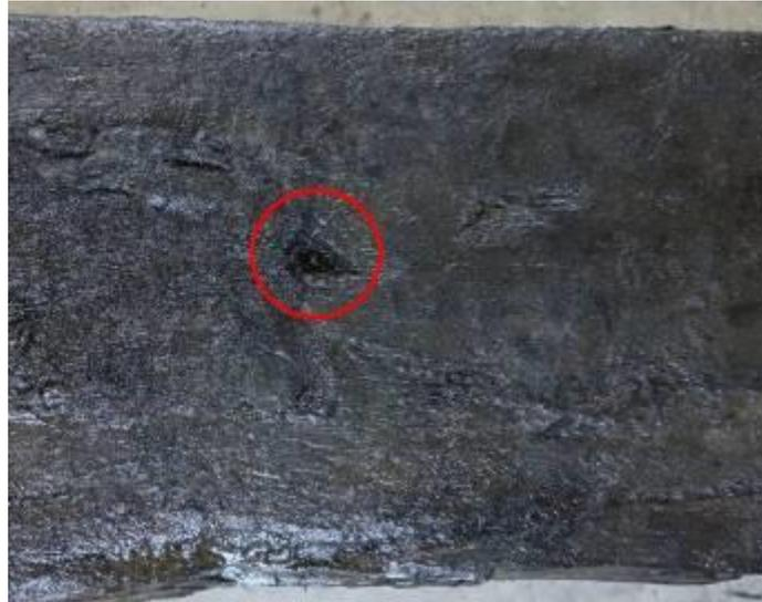
**Figura 126** – EDP\_0097(A), a única tábuca de forro exterior onde se registou um prego com a cabeça triangular embutida.
