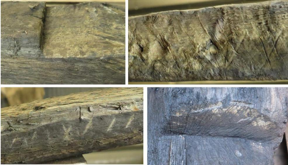
**Figura 208** - Exemplos de marcas de serra e de machado ou enxó registadas em BV1.
