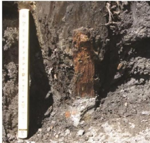
**Figura 48** – Estacas em madeira de secção circular e ponteira metálica (Fotos: arquivo ERA).
