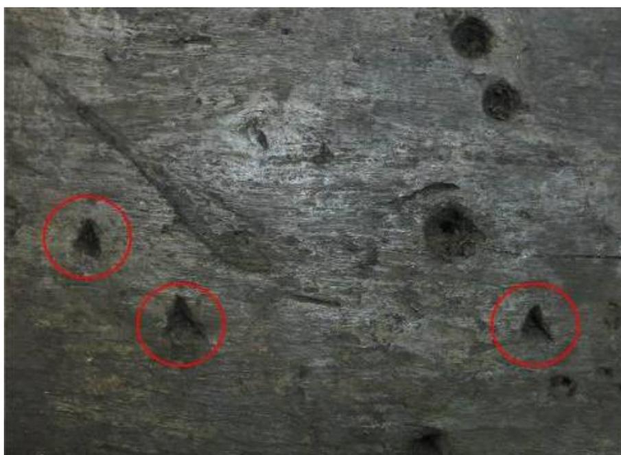
**Figura 138** – Marcas incisas na face exterior das peças EDP\_0095B e C.
