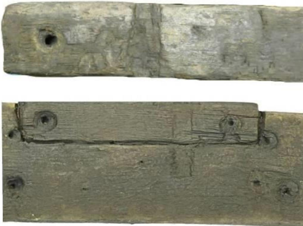
**Figura 128** – Marca existente entre os remendos de forro exterior e as tábuas do forro exterior (EDP\_0464 e EDP\_0198).
