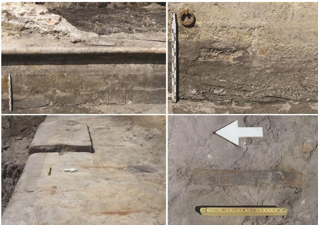
**Figura 58** – Estrutura de contenção, argolão e grampos existentes entre os blocos de pedra que integravam o paredão (Fotos: arquivo ERA).
