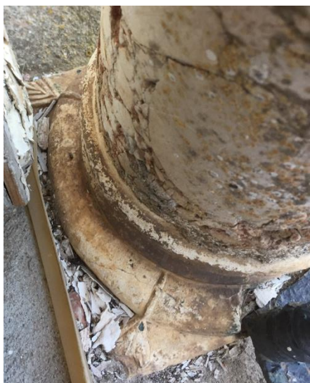
Fig. 14 - Pormenor da base da coluna da janela, Palácio Cadaval; Leonor Nogueira, 2022.
