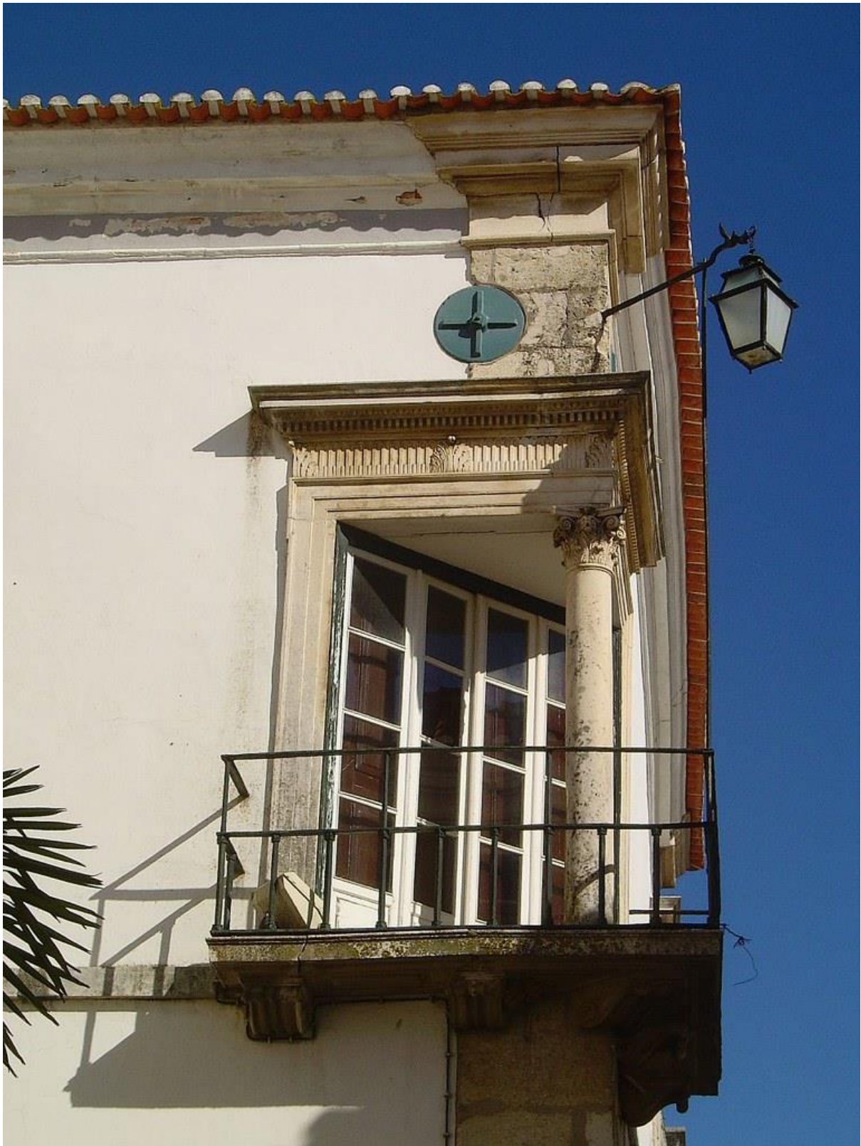
Anexo 6 - Exemplo de janela de canto em Santarém, 1939; GISA - Arquivo Municipal do Porto (site: https://gisaweb.cm-porto.pt/units-of-description/documents/260340/? );
