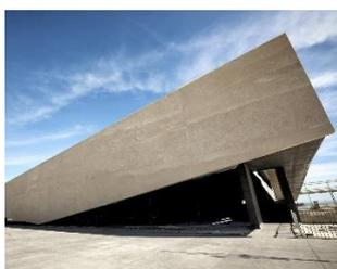
Foi identificada a necessidade de recurso a um betão estrutural leve, de forma a reduzir o peso da estrutura do edifício sem comprometer a sua resistência. A opção recaiu na utilização de granulados de cortiça natural como agregado leve.
