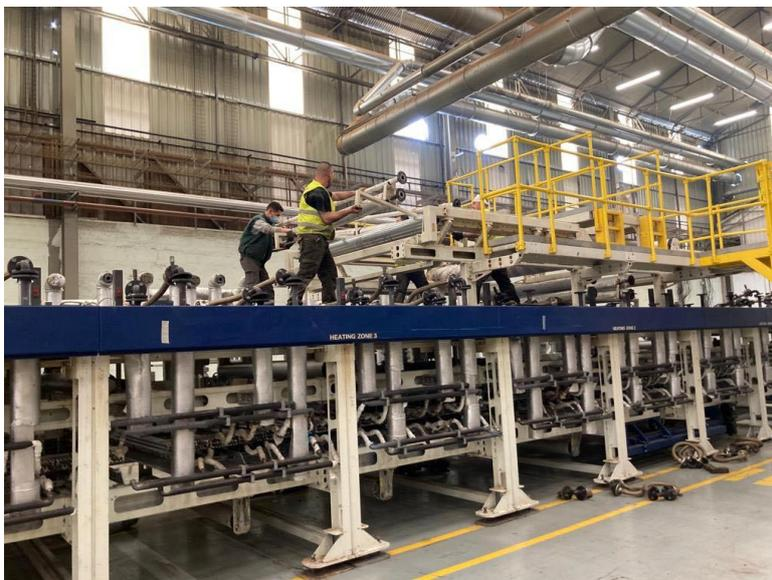
Figura 41 – Nova Prensa parcialmente montada no local
