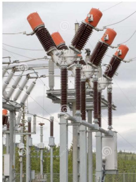
Fig. 9 - Disjuntores Alta Tensão [20]
