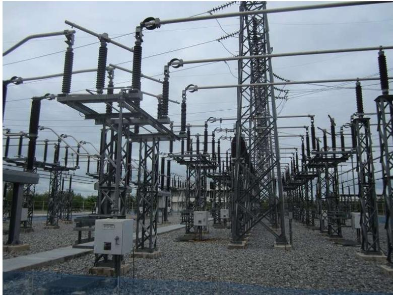
Fig. 8 – Seccionadores tripolar de Alta Tensão [18]
