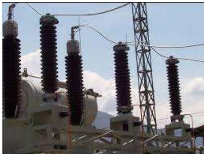
Fig. 12 - Descarregadores de Sobretensões [22]
