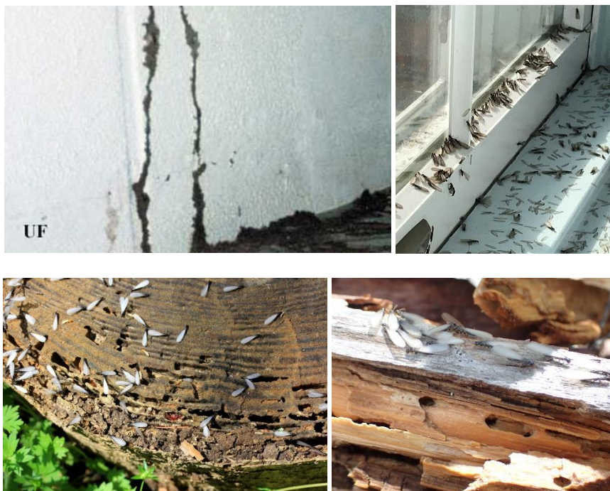
Figura ApE55 - Evidências de atividade de térmitas da espécie R. flavipes . Da esquerda para a direita: Tubos de trabalho (Su, N-Y. & Scheffrahn, R.H., 2019); Indivíduos reprodutores alados durante a enxameação, no peitoril de uma janela (a maioria já perdeu as asas) (Sean Wellman, 2019); Galerias de alimentação em madeiras (Chris Buelow, 2022; Jim Walker, 2022).
