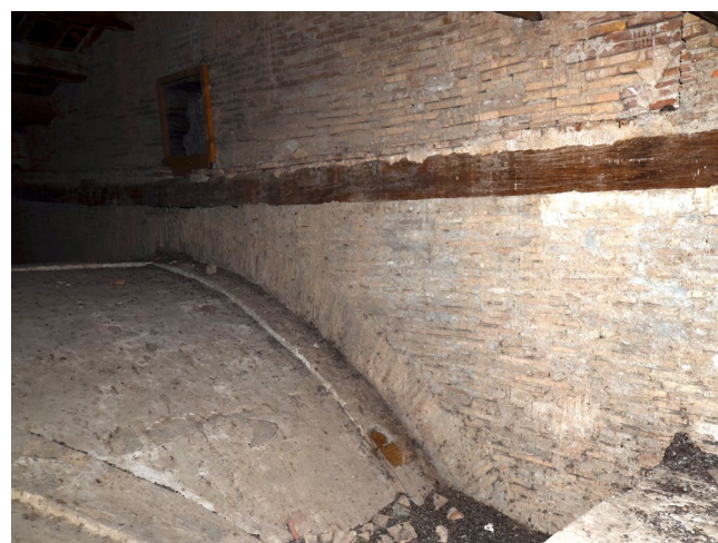
Figura 21. Construcción bóvedas tabicadas bajo la cubierta.
