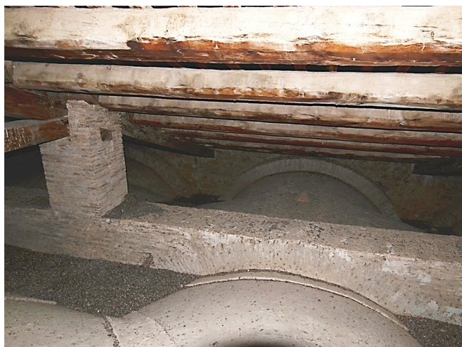
Figura 18. Enrasado sobre los arcos formeros para asentar la cubierta.
