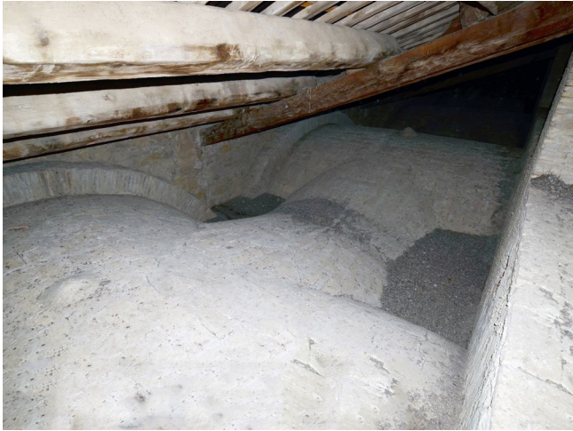
Figura 22. Bóvedas tabicadas naves colaterales.
