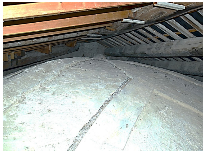
Figura 7. Extradós bóvedas de rincón con lunetos transepto [Tl.1, Tr.1].
