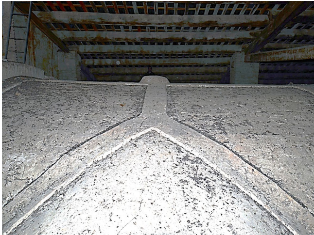
Figura 8. Extradós bóvedas nave central [VC1, VC2, VC3, VC4].
