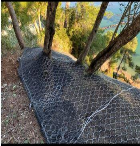
Εικόνα 6-3. Αποκατάσταση κατολίσθησης πρσανούς. Πηγή: Προσωπικό αρχείο
