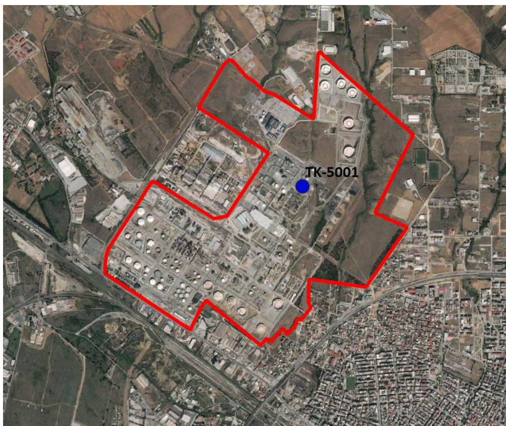
Εικόνα 3.28. Η θέση της δεξαμενής TK-5001 στη βιομηχανική εγκατάσταση των ΕΛ.ΠΕ., ίδια επεξεργασία στο λογισμικό QGIS
