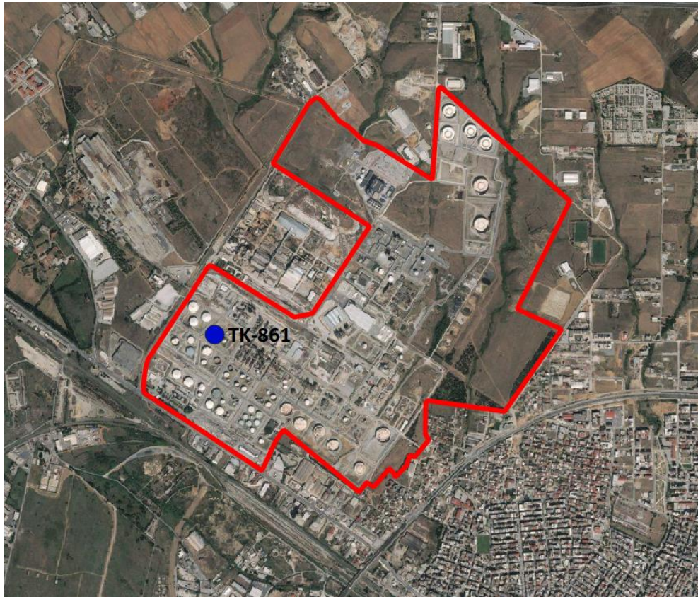
Εικόνα 3.22. Η θέση της δεξαμενής TK-861 στη βιομηχανική εγκατάσταση των ΕΛ.ΠΕ., ίδια επεξεργασία στο λογισμικό QGIS
