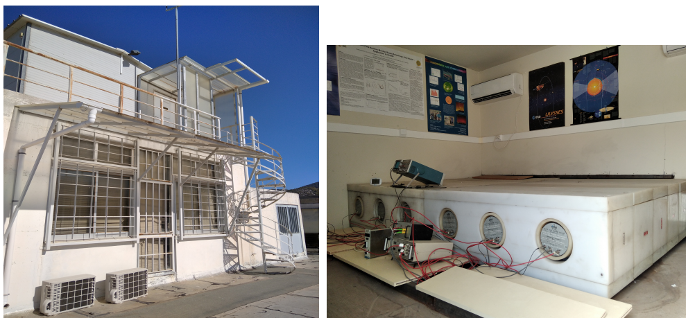
Σχήμα 3.6: Το κτήριο που φιλοξενεί (αριστερά) το Μετρητή Νετρονίων Κοσμικής Ακτινοβολίας (δεξιά) της Αθήνας.
