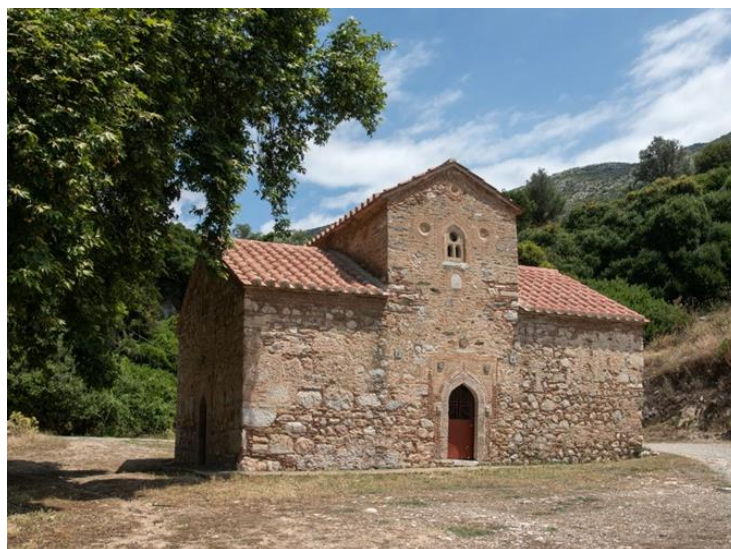
Εικόνα 51 Ναός Ζωοδόχου Πηγής (ΕΦ.Α. Ευβοίας, Ναός Ζωοδόχου Πηγής, 2014.)
