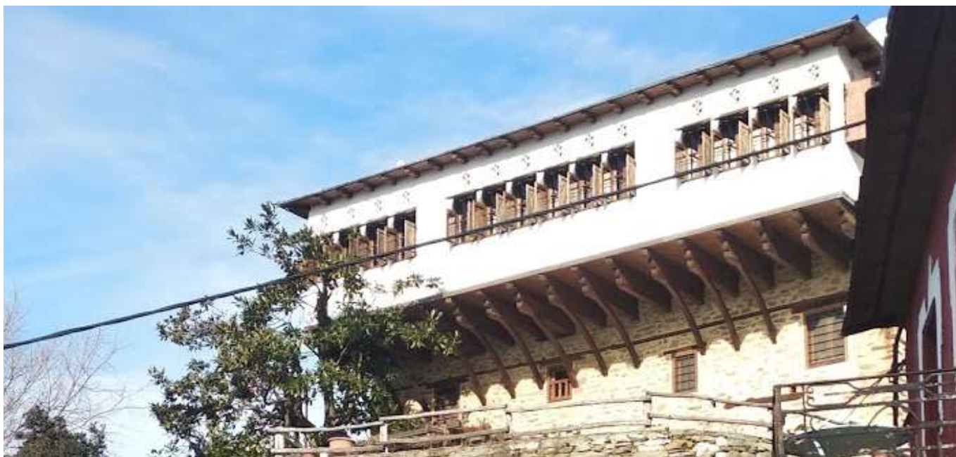
99. Οικία Ζαρίφη, νοτιοανατολική άποψη μετά τις εργασίες ανακαίνισής και την αποκατάσταση του ξύλινου εξώστεγου.
