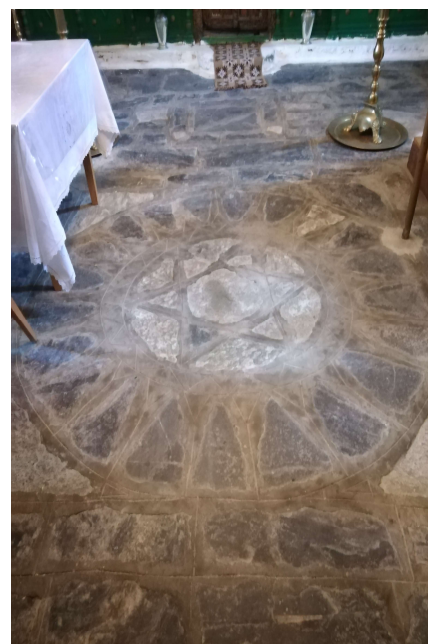
72. Πλακόστρωτο δάπεδο στο εσωτερικό του ναού, με το θέμα τού πεντάκτινου αστέρος – πεντάλφα, να αναπτύσσεται στο κέντρο του.
