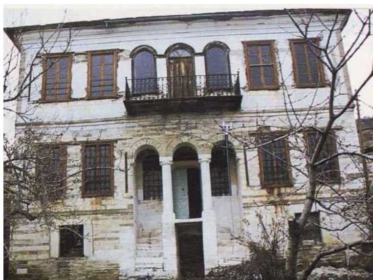
137. Οικία Πέτρου Μίλλερ, νοτιοδυτική όψη. Διακρίνεται το τρίλοβο προστώο της εισόδου με τη διπλή κλίμακα και η ανεξάρτητη πόρτα προς το ημιυπόγειο.
