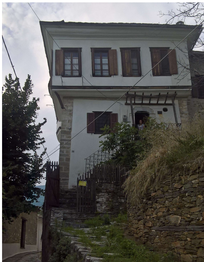
125. Αρχοντικό Γεώργιου Σίνη, νοτιοανατολική όψη. Διακρίνεται το νεότερο εξωτερικό κλιμακοστάσιο εισόδου στην οικία.
