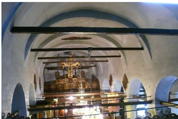
57. Τμήμα της διαμήκης ημικυλινδρικής καμάρας όπως διαμορφώνεται στο κεντρικό κλίτος.
