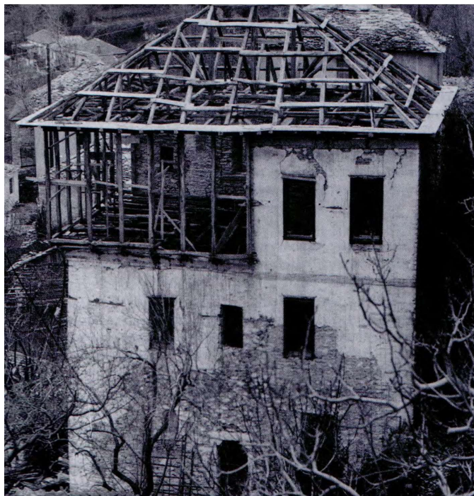
105. Χαρακτηριστικό της περιόδου ακμής, η οχυρή πέτρινη βάση σε συνδυασμό με τη ξύλινη κατασκευή που αναπτύσσεται στο τελευταίο όροφο.
