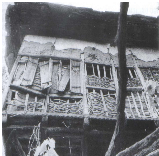
107. Σαχνίσι πηλιορείτικου αρχοντικού. Διακρίνεται το εσωτερικό του τοιχοπετάσματος κατασκευασμένο από μπαγδατί.
