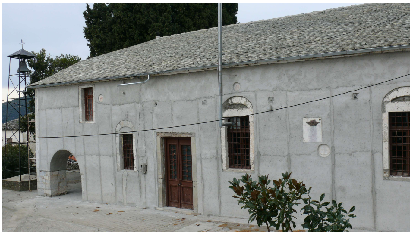
158. Ναός Αγίου Δημητρίου κατά τη διάρκεια των εργασιών ενίσχυσης της περιμετρικής εξωτερικής τοιχοποιίας.
