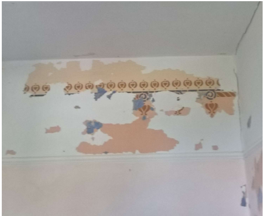
128. Οικία Έφης Λιάτζουρα, τμήμα τοιχογραφίας που αποκαλύφθηκε κατά τις εργασίες αποκατάστασης.
