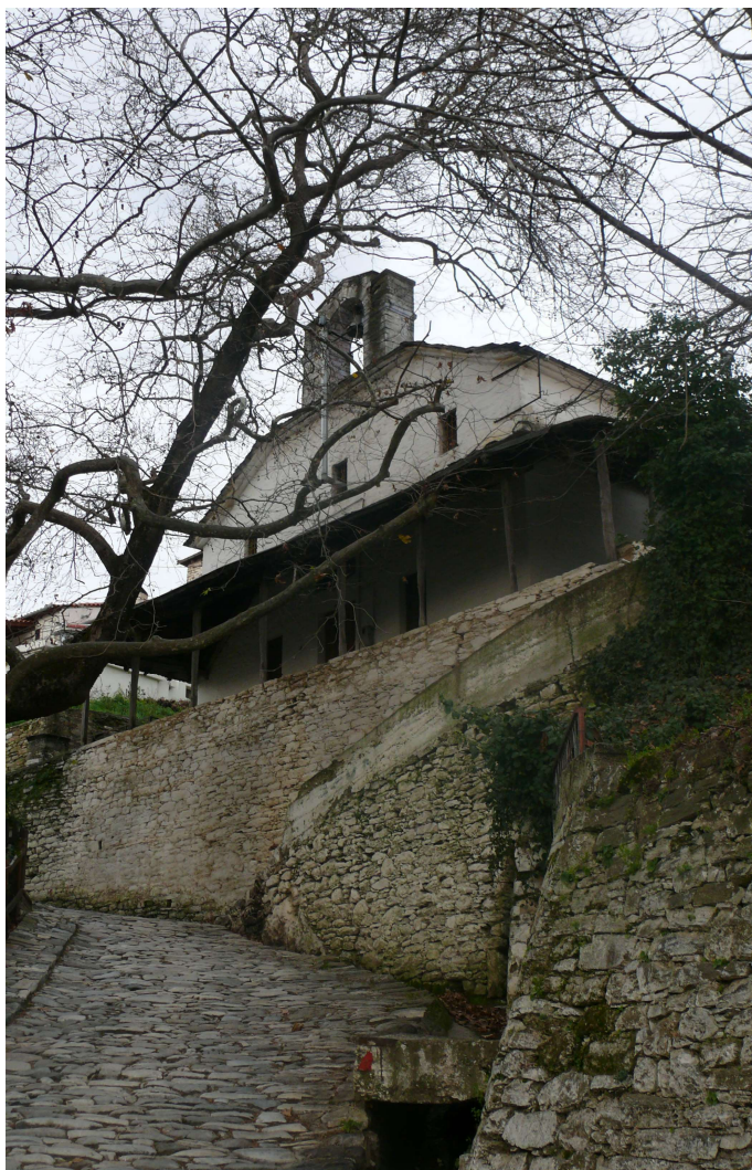
65. Εξωτερική άποψη του ναού του Αγίου Αθανασίου από δυτικά.
