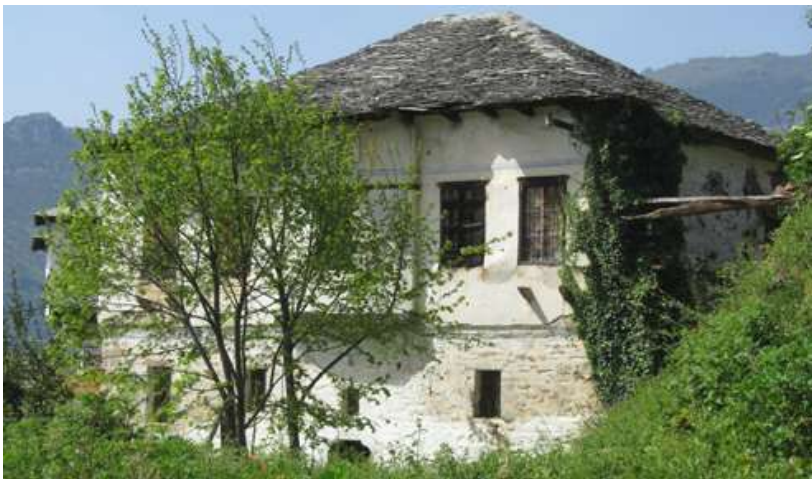
130. Οικία Ζαρίφη Αλέξη, νότια όψη.
