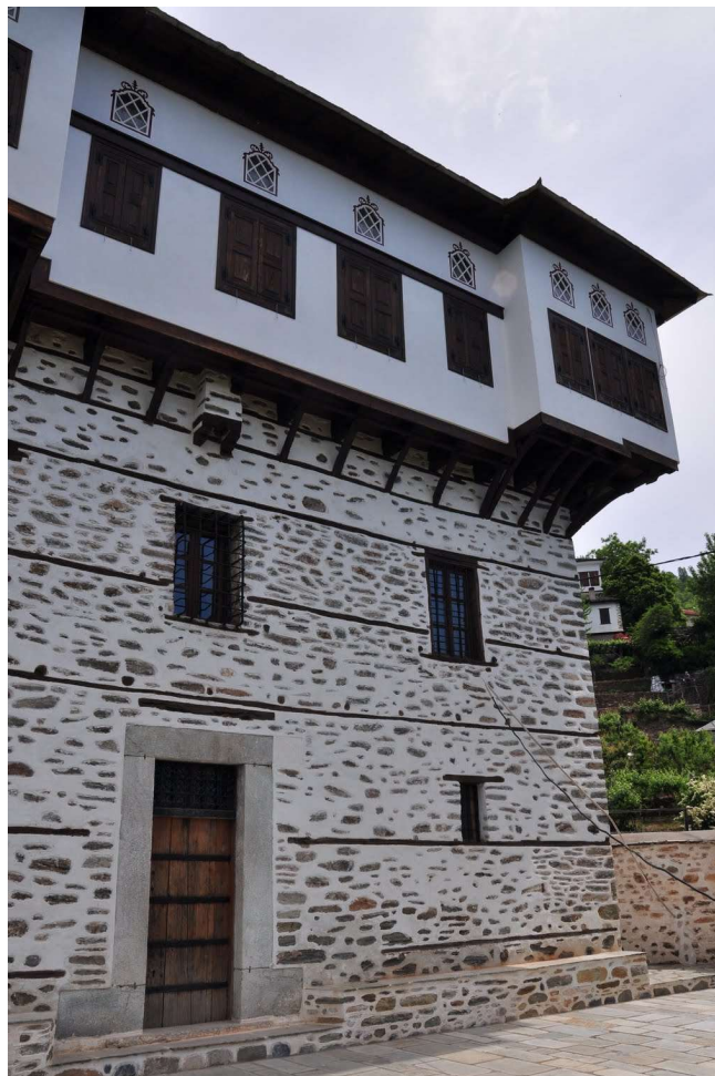
112. Αρχοντικό Γκλαβάνη, νοτιοδυτική όψη. Διακρίνεται η καταχύστρα αξονικά και πάνω από τη θύρα εισόδου στο δάπεδο του τελευταίου ορόφου.
