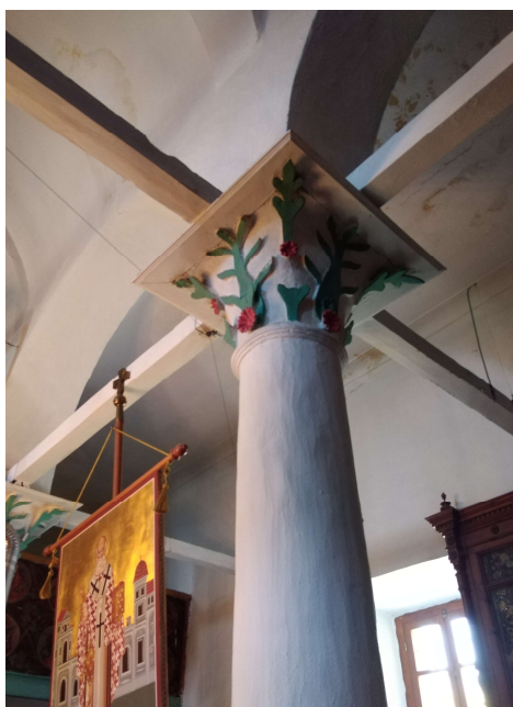
70. Άποψη εσωτερικού ναού Αγίου Αθανασίου. Κίονας κυκλικής διατομής μεταξύ κεντρικού και πλευρικού κλιτίους.
