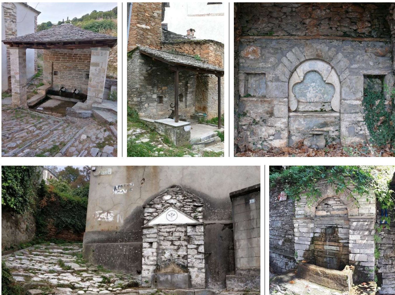
34. Χαρακτηριστικές κρήνες στο εσωτερικό του οικισμού.
