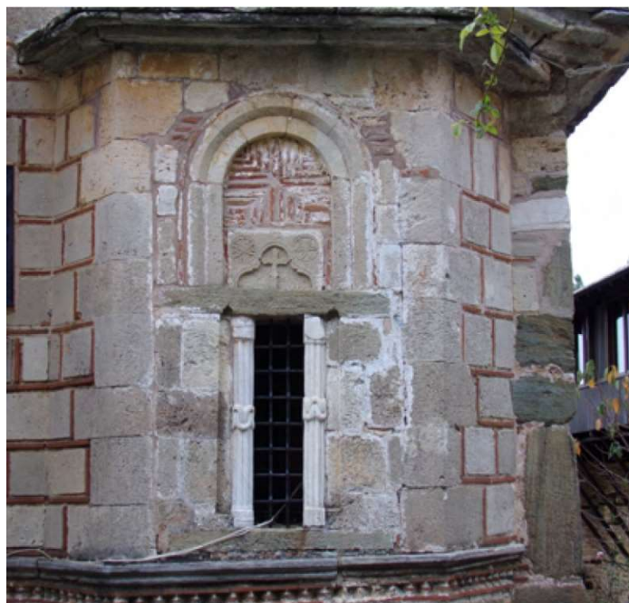
51. Παράθυρο δεξιάς κόγχης. Διακρίνονται οι μαρμαρίνοι κιονίσκοι που το πλαισιώνουν και το τοξωτό υπέρθυρο.
