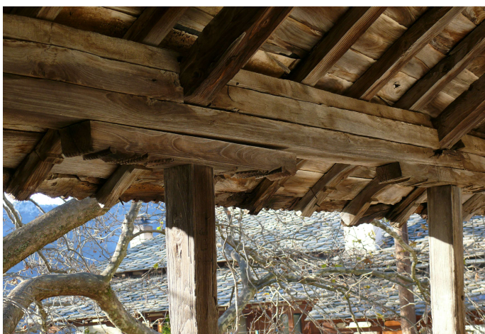
75. Τμήμα της ξύλινης κατασκευής της εξωτερικής στοάς όπου διακρίνονται τα υποστυλώματα της μονόριχτης στέγης.
