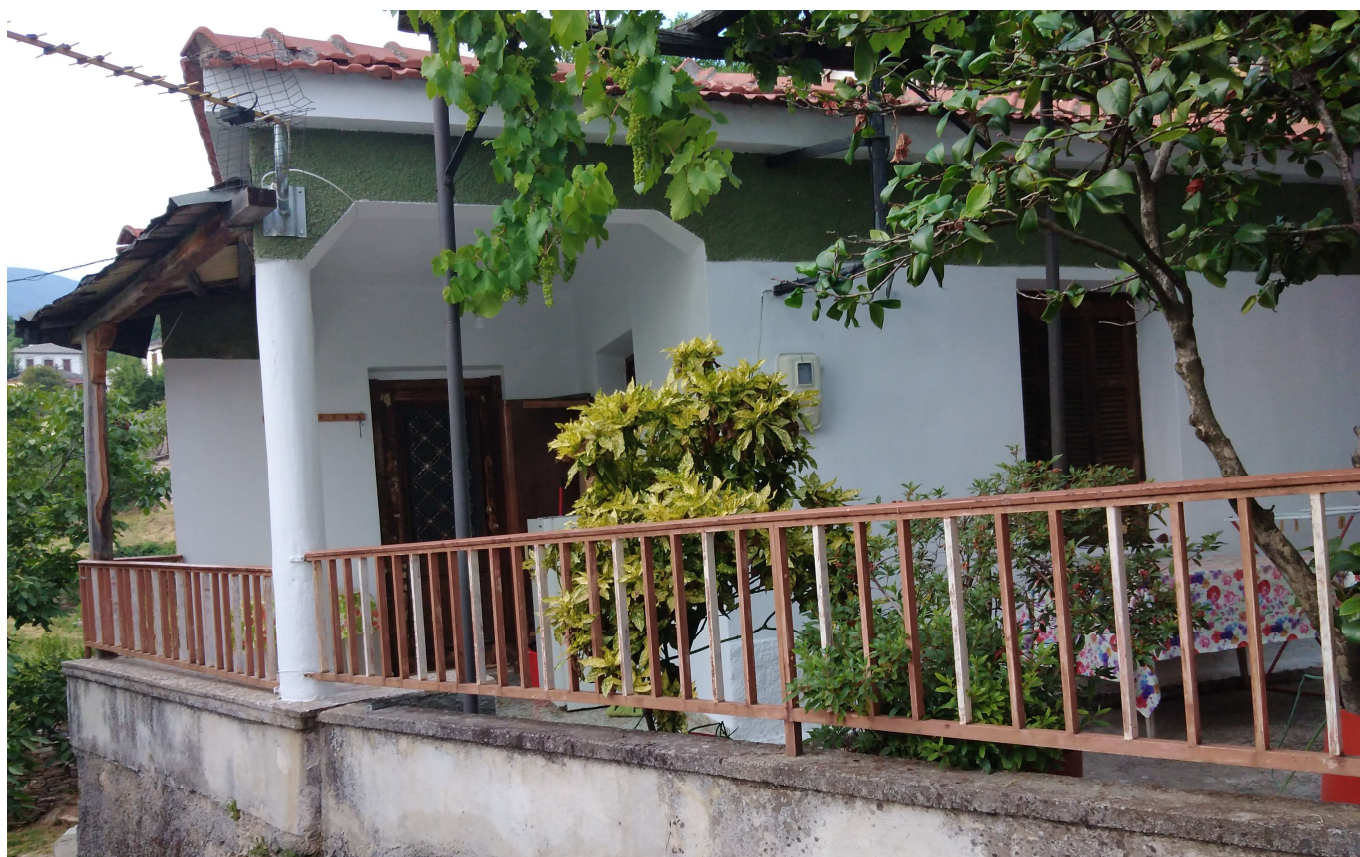
151. Δείγμα αντισεισμικής κατοικίας σύμφωνα με το δομικό σύστημα «Παρασκευοπούλου» εντός του οικισμού.
