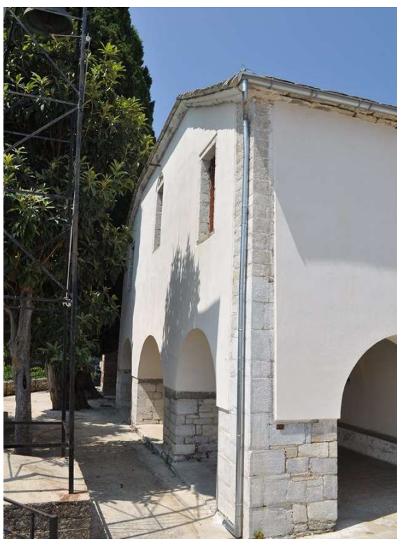
70. Δυτική όψη, Ναός Αγίου Δημητρίου. Διακρίνεται η στοά με τον υπερκείμενο γυναικωνίτη.
