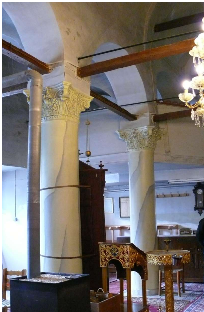
59. Κίονες σε απομίμηση μαρμάρου που φέρουν κορινθιακά κιονάκρانا. Άποψη εσωτερικού ναού Αγίου Δημητρίου.
