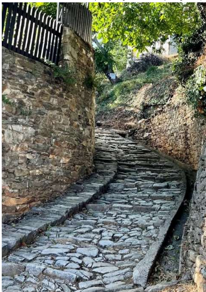
37. Τμήματα από το δίκτυο καλντεριμιών εντός του οικισμού. Διακρίνεται η μικρή ανύψωση που δημιουργείται και λειτουργεί ως “πεζοδρόμιο” καθώς και το αυλάκι για την απορροή των υδάτων.
