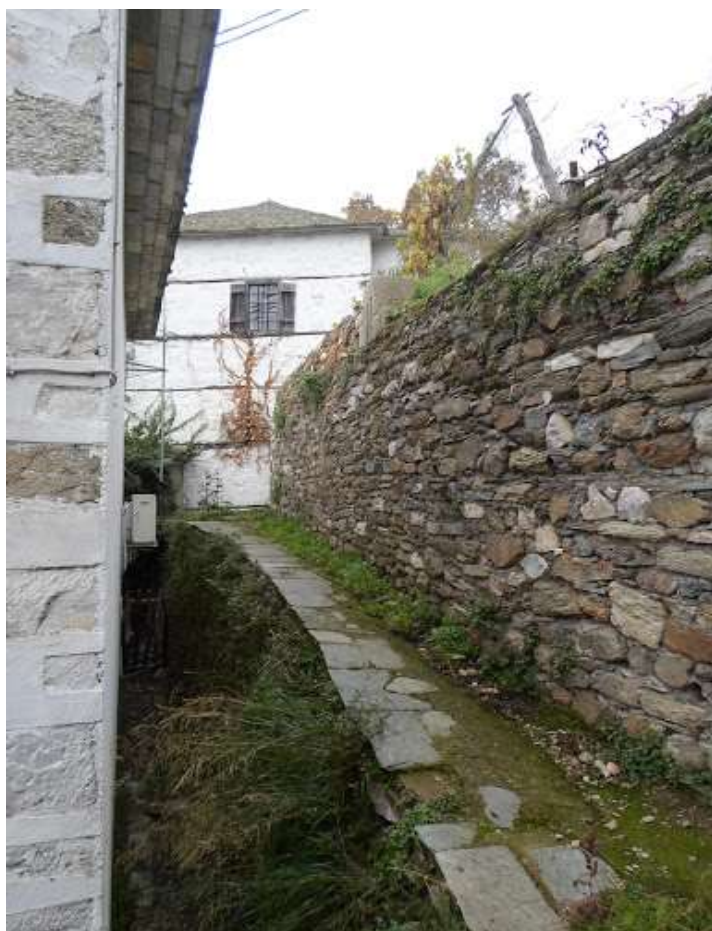
29. Χαρακτηριστικό παράδειγμα "αστρέχας" που αφήνεται στο πίσω όριο οικοπέδου για την απορροή των όμβριών.
