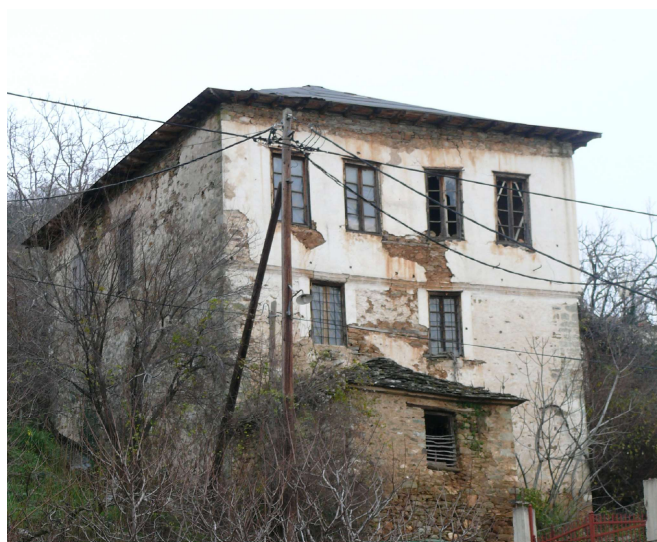
143. Ανώνυμη εγκαταλελειμμένη οικία, νοτιοδυτική άποψη.
