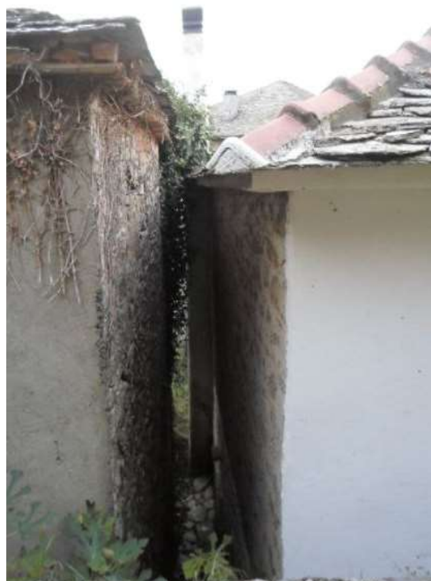
30. Παράδειγμα "αστρέχας" μεταξύ των ιδιοκτησιών με απουσία μεσοτοιχίας.
