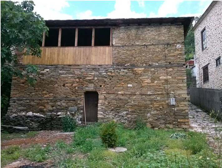
103. Κτίριο Πέτρου Μίλλερ. Στη τοιχοποιία της νότιας όψης του διακρίνονται ίχνη ύπαρξης ξύλινου εξώστεγου.
