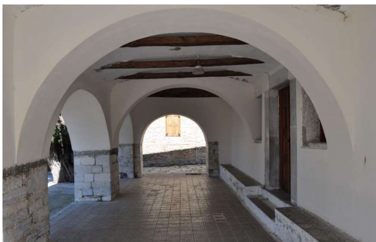
61. Τοξωτή στοά, δυτική όψη ναού Αγίου Δημητρίου.
