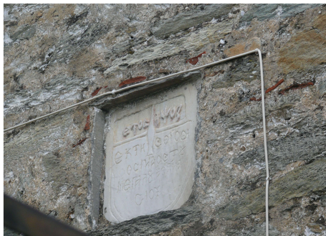
66. Λίθινη ανάγλυφη επιγραφή στη βόρεια όψη που αναφέρει το 1777 ως έτος ανέγερσης του ναού.
