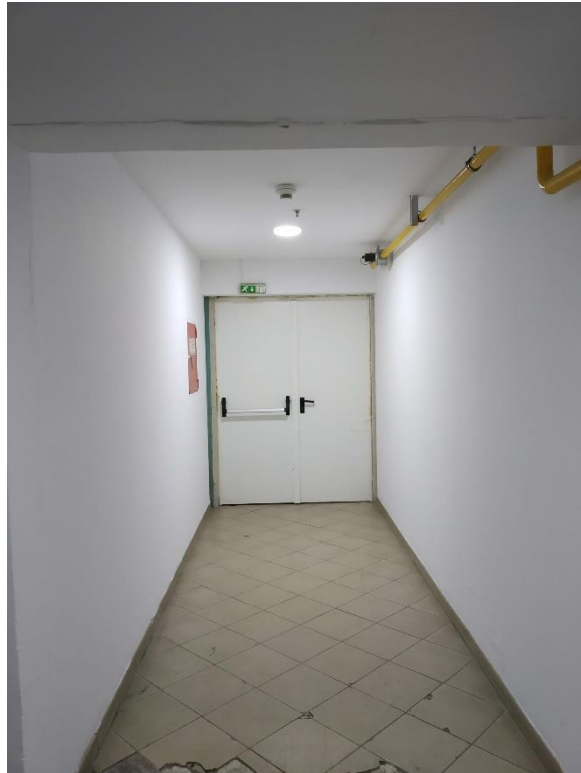
Σχήμα 27: Φωτογραφία εσωτερικής εξόδου κινδύνου/διαφυγής στο “Makedonia Palace”.
