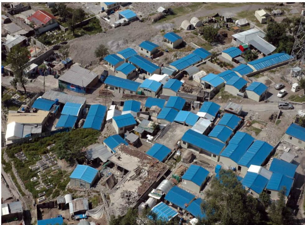
Εικόνα 5.20. Προκατασκευασμένα καταλύματα στο Kashmir (The New Humanitarian).
