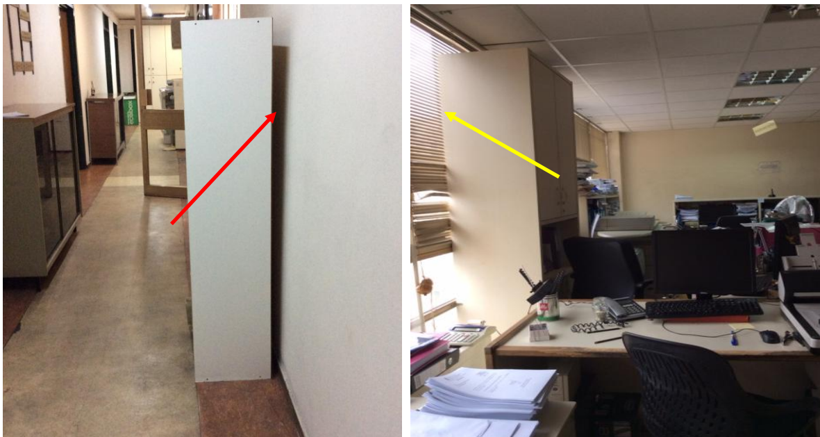
Εικόνα 4-9. Αστήριχτες ντουλάπες, ελεύθερα εδραζόμενες κατά μήκος της όδευσης διαφυγής και στο εσωτερικό των γραφείων
