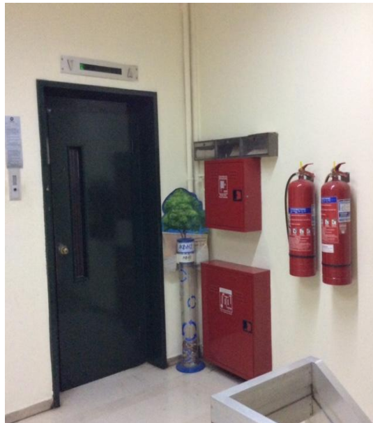
Εικόνα 4-2. Σύστημα πυρόσβεσης στο λεβητοστάσιο του υπογείου και μέσα πυρόσβεσης στο ισόγειο
