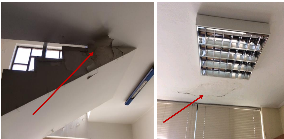
Εικόνα 4-14. Ρηγματώσεις και αποκολλήσεις επιχρισμάτων στην οροφή της πλάκας πάνω από το κλιμακοστάσιο και σε χώρο γραφείου
