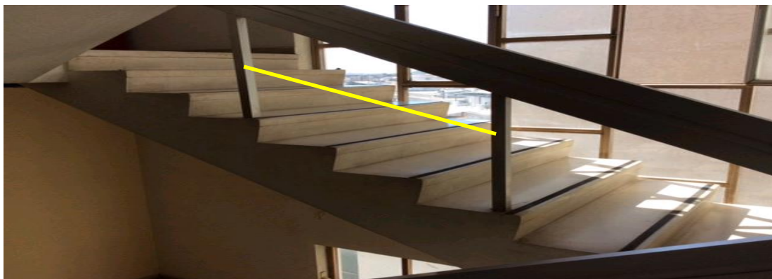
Εικόνα 4-10. Η μεγάλη απόσταση των ορθοστατών αποτελεί κίνδυνο για την ασφάλεια των χρηστών
