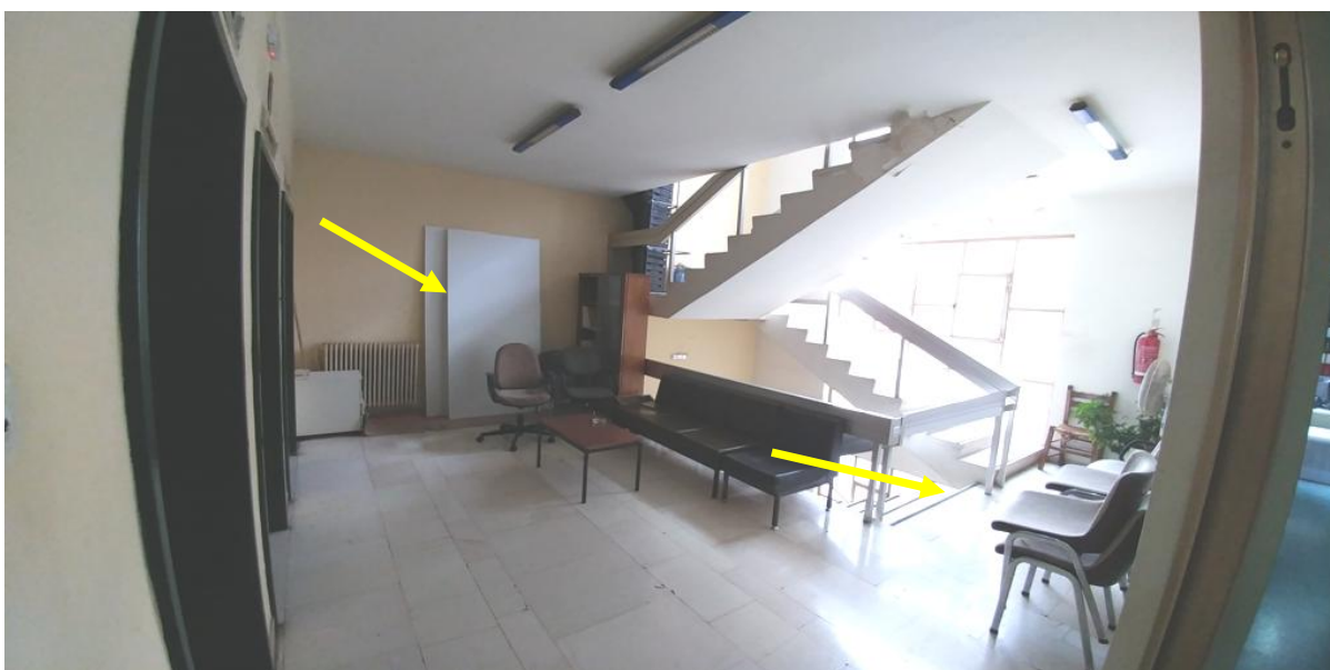
Εικόνα 4-11. Κιβώτιο με Πυροσβεστικά Εργαλεία και έπιπλα σε χώρο του κλιμακοστασίου
