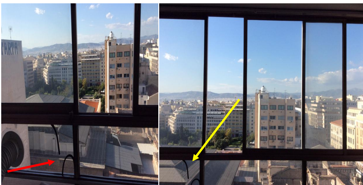
Εικόνα 4-8. Υαλοστάσια γραφείων που βλέπουν στην οδό Σταδίου Πηγή: Η φωτογραφία ελήφθη κατά τη διάρκεια της αυτοψίας στο κτήριο στις 16 .12. 2016
