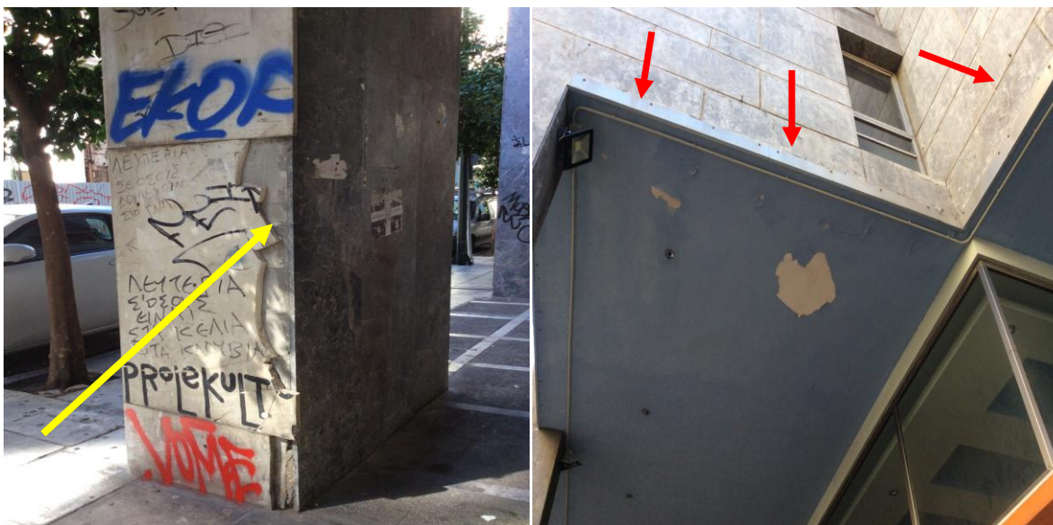
Εικόνα 4-7. Αποκολλήσεις μαρμάρων σε υποστύλωμα του κτηρίου επί της Σταδίου και Χρ. Λαδά Πηγή: Η φωτογραφία ελήφθη κατά τη διάρκεια της αυτοψίας στο κτήριο στις 16 .12. 2016
