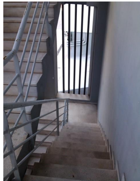
Εικόνα 30. Εξωτερικά βοηθητικά κλιμακοστάσια του κτιρίου (έξοδοι κινδύνου)
