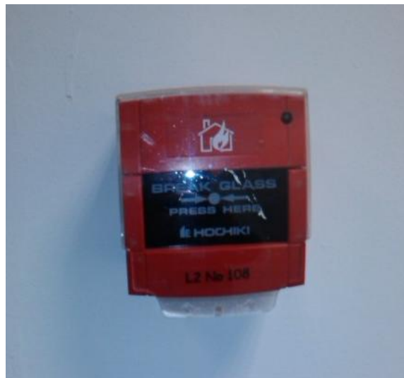
Εικόνα 31. Πόρτες εξόδου κινδύνου (α) – Μπουτόν αναγγελίας φωτιάς (β)
