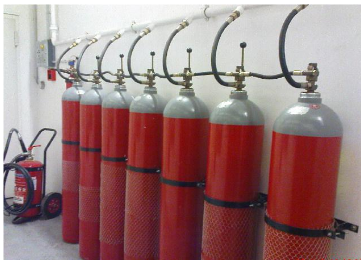
Εικόνα 32. Πυροσβεστικός σταθμός, πυροσβεστική φωλιά (α) – Συστήματα κατάσβεσης CO 2 (β)
