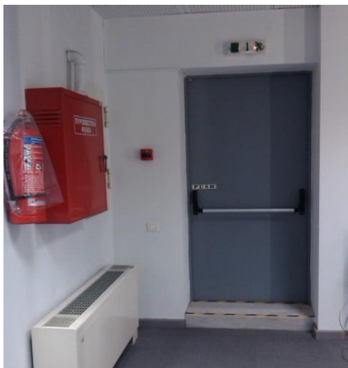
Εικόνα 31. Πόρτες εξόδου κινδύνου (α) – Μπουτόν αναγγελίας φωτιάς (β)
