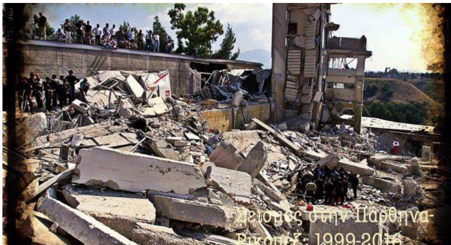
Εικόνα 2. Το κτίριο της Ρικομέξ μετά τον σεισμό της Πάρνηθας το 1999 (πηγή: thessi.gr, 2016)
