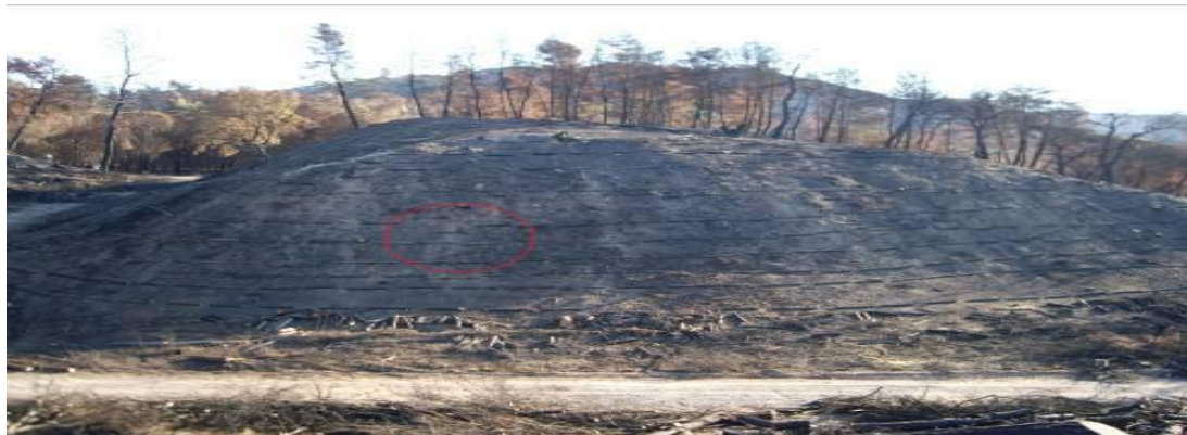
Εικόνα 24. Διάταξη κορμοδεμάτων τύπου «μωσαϊκού» στο λόφο Καλόσακα της αρχαίας Ολυμπίας (Πηγή: http://www.nagref.gr ).
