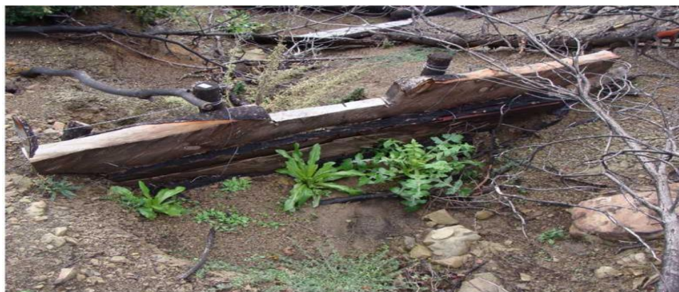
Εικόνα 21. Κορμόφραγμα στην περιοχή της Σμέρνας Ηλείας (Πηγή: Μαρτζάκλης, 2009).
