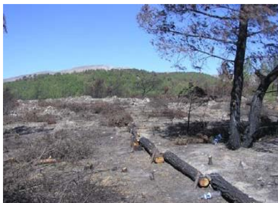
Εικόνα 26. Κατασκευή κορμοδεμάτων σε θέση με μικρή κλίση εδάφους (Πηγή: Μάρης και Θεοφάνους, 2008).
