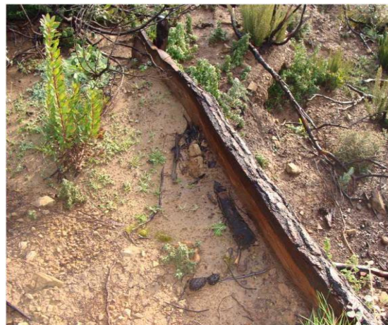
Εικόνα 20. Κορμόδεμα στην περιοχή της Σμέρνας Ηλείας (Πηγή: Μαρτζάκλης, 2009).
