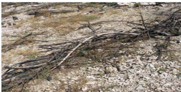
Εικόνα 18. Εσφαλμένη κατασκευή κλαδοπλέματος στην περιοχή της Πάρνηθας (Πηγή: Ντούβλης, 2010).
