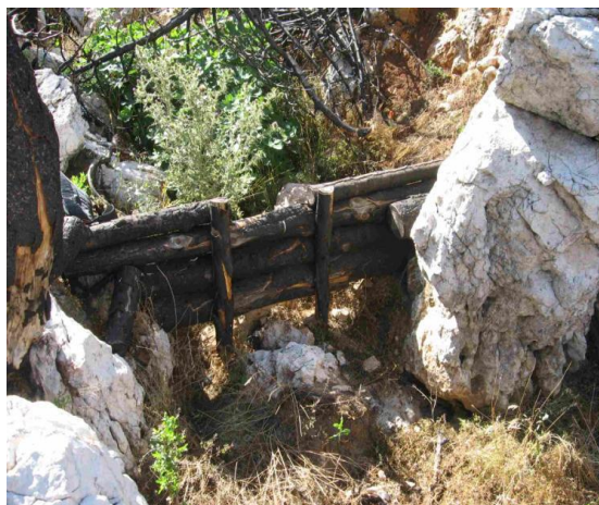
Εικόνα 17. Αποτυχημένο κορμόφραγμα στην περιοχή της Πάρνηθας, όπου η υποσκαφή είναι εντονότατη (Πηγή: Ντούβλης, 2010).
