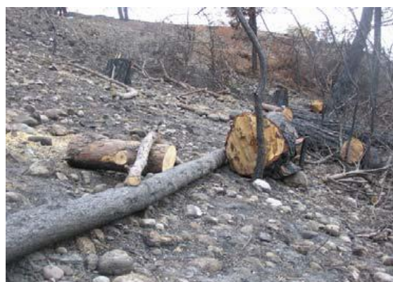
Εικόνα 29. Κορμόδεμα με ανομοιόμορφο ύψος (Πηγή: Μάρης και Θεοφάνους, 2008).
