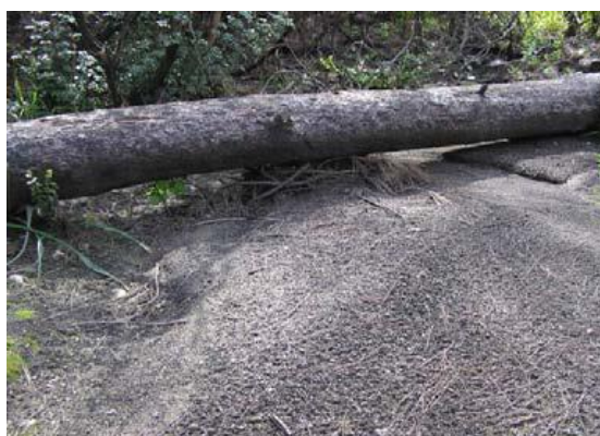
Εικόνα 28. Δημιουργία κενών μεταξύ εδάφους και κορμοδεμάτων (Πηγή: Μάρης και Θεοφάνους, 2008).
