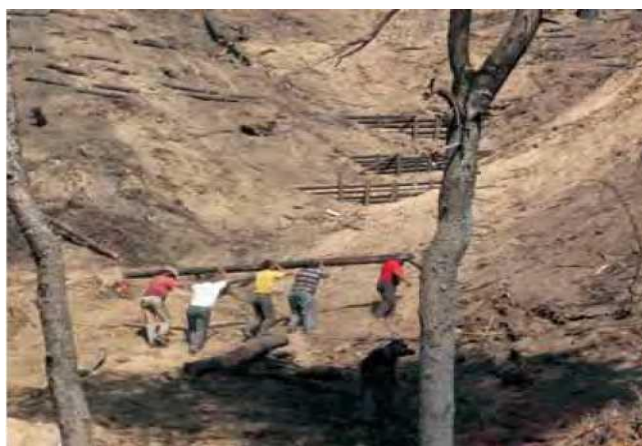
Εικόνα 25. Κορμοφράγματα στην περιοχή της Αρχαίας Ολυμπίας (Παράλληλα, απεικονίζεται η αποφασιστικότητα και η θέληση των μελών των δασικών συνεταιρισμών για την προστασία του εδάφους από τη διάβρωση, με τη μικρότερη και αναπόφευκτη διατάραξη του χώρου) (Πηγή: Μπαλούτσος, 2008).
