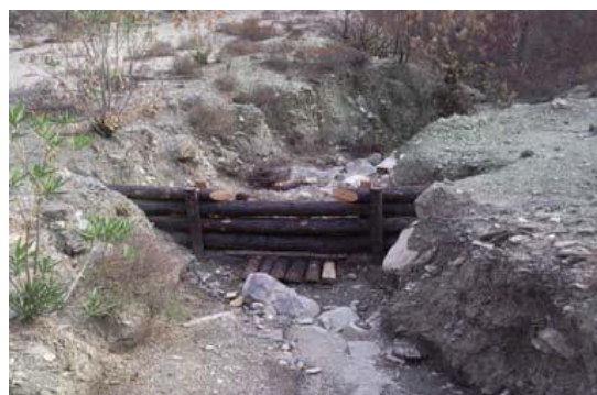
Εικόνα 31. Κατασκευή κορμοφράγματος σε θέση με χαλαρό εδαφικό υλικό (Πηγή: Μάρης και Θεοφάνους, 2008).
