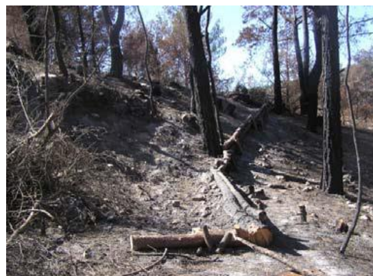
Εικόνα 27. Κορμοδέματα που δεν κατασκευάστηκαν κατά τις ισοϋψείς καμπύλες (Πηγή: Μάρης και Θεοφάνους, 2008).
