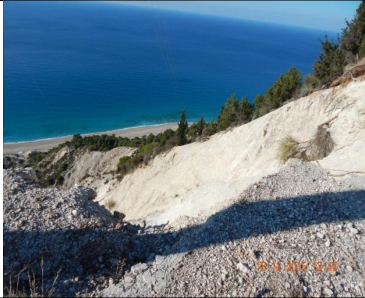
Κατολίσθηση από το μέρος του πρανούς, αποτέλεσμα του σεισμού Τρίτης 17 Νοεμβρίου 2015.
