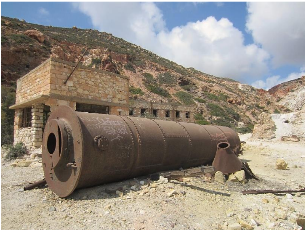
Εικόνα 51: Το κτίριο του Σχεδιαστήριου στην είσοδο του βιομηχανικού συγκροτήματος, αποκομμένο από τα υπόλοιπα κτίρια του συγκροτήματος. Στο έδαφος μπροστά του κείται τμήμα του λέβητα παραγωγής υπέρθερμου ατμού για την διαδικασία της επίπλευσης του μεταλλεύματος, φωτ. προσωπικό αρχείο γράφουσας.
