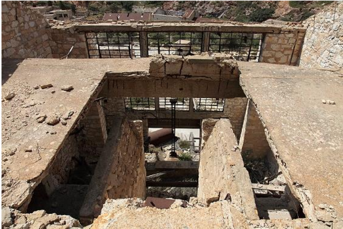
Εικόνα 43: Σιλό για την αποθήκευση του μεταλλεύματος και τη μεταφορά του στις εγκαταστάσεις επίτλευσης, πηγή: www.photonvolcanica.com .
