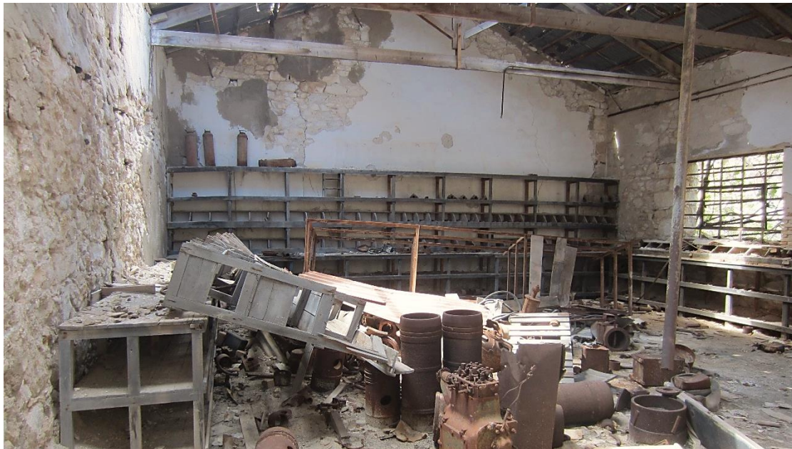
Εικόνα 33: Εσωτερική άποψη της αποθήκης, όπου σώζονται μέχρι σήμερα τα ξύλινα ερμάρια για την αποθήκευση των ανταλλακτικών, φωτ. προσωπικό αρχείο γράφουσας.
