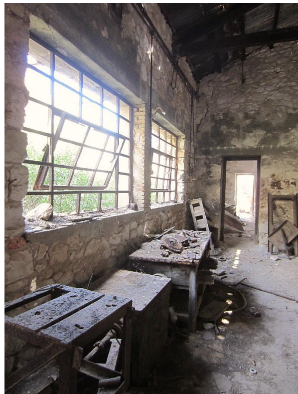
Εικόνα 48: Κατάρρευση στέγης στο εσωτερικό του Μηχανοστασίου (αριστερά) και διάβρωση μεταλλικών κουφωμάτων στο κτίριο του Μηχανουργείου-Σιδηρουργείου (δεξιά), φωτ. προσωπικό αρχείο γράφουσας.
