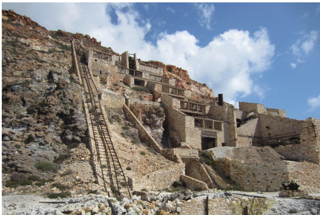
Εικόνα 28: Αναβατήρας με βαγονέτα τύπου Decauville για τη μεταφορά των μεταλλευμάτων, φωτ. προσωπικό αρχείο γράφουσας.
