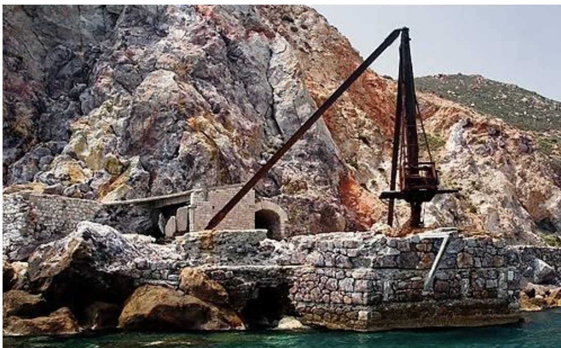
Εικόνα 41: Αποβάθρα φόρτωσης με μεταλλικό πρόβολο στην άκρη της ακτής, για τη θαλάσσια μεταφορά του προϊόντος, πηγή: www.ajournaliv.ru .
