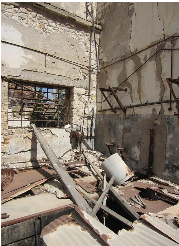
Εικόνα 48: Κατάρρευση στέγης στο εσωτερικό του Μηχανοστασίου (αριστερά) και διάβρωση μεταλλικών κουφωμάτων στο κτίριο του Μηχανουργείου-Σιδηρουργείου (δεξιά), φωτ. προσωπικό αρχείο γράφουσας.
