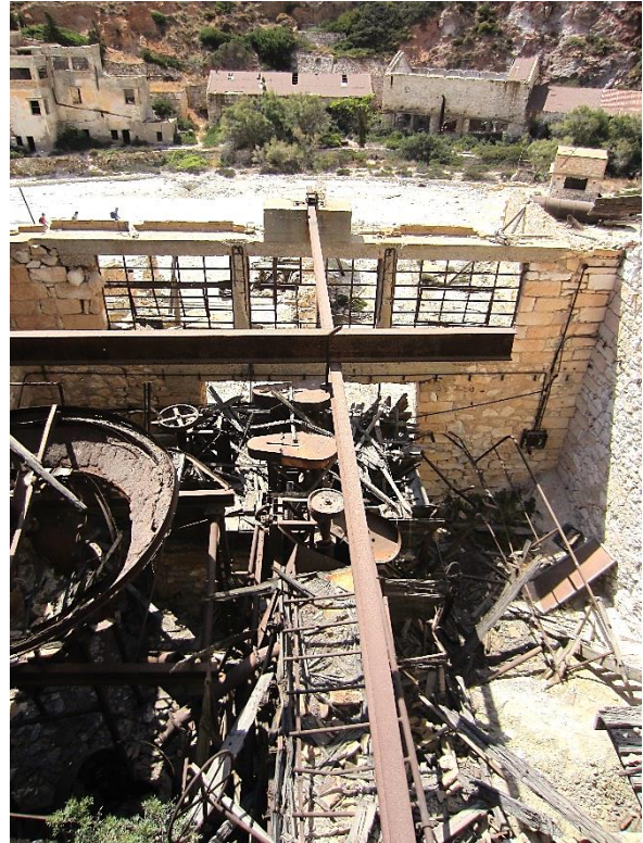
Εικόνα 45: Το κτίριο της θραύσης και της επίπλευσης του θείου έχει υποστεί σήμερα εκτεταμένες φθορές στην λιθοδομή, στα κουφώματα, αλλά και στο εσωτερικό του με την κατάρρευση της στέγης, φωτ. προσωπικό αρχείο γράφουσας.
