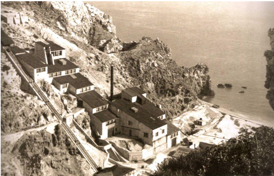
Εικόνα 21: Οι εγκαταστάσεις εμπλουτισμού από το κτιριακό συγκρότημα των θειωρυχείων, δεκαετία του '30, πηγή: www.enet.gr .
