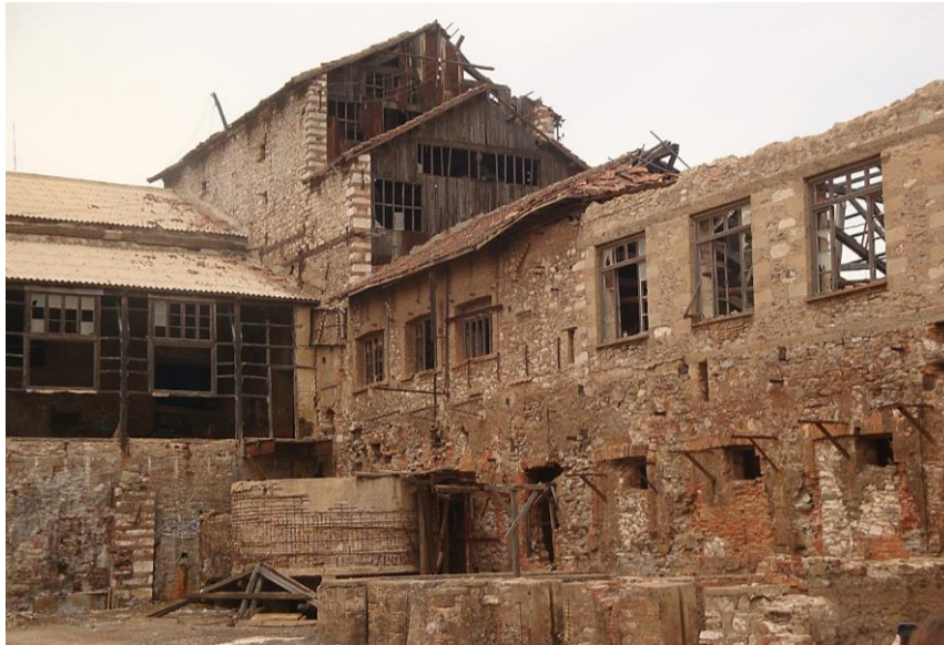
Εικόνα 69: Εγκαταστάσεις της Γαλλικής Εταιρείας Λαυρίου, που δεν έχουν ακόμη αποκατασταθεί, φωτ. προσωπικό αρχείο γράφουσας.
