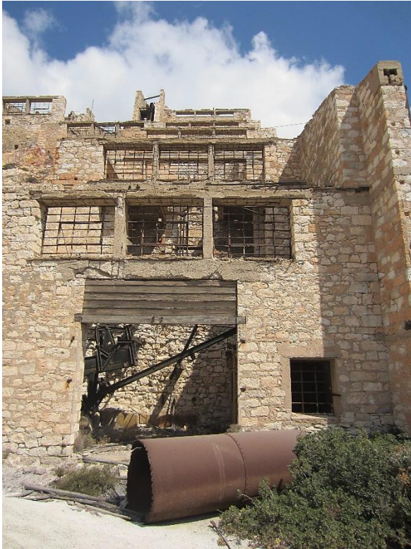
Εικόνα 45: Το κτίριο της θραύσης και της επίπλευσης του θείου έχει υποστεί σήμερα εκτεταμένες φθορές στην λιθοδομή, στα κουφώματα, αλλά και στο εσωτερικό του με την κατάρρευση της στέγης, φωτ. προσωπικό αρχείο γράφουσας.
