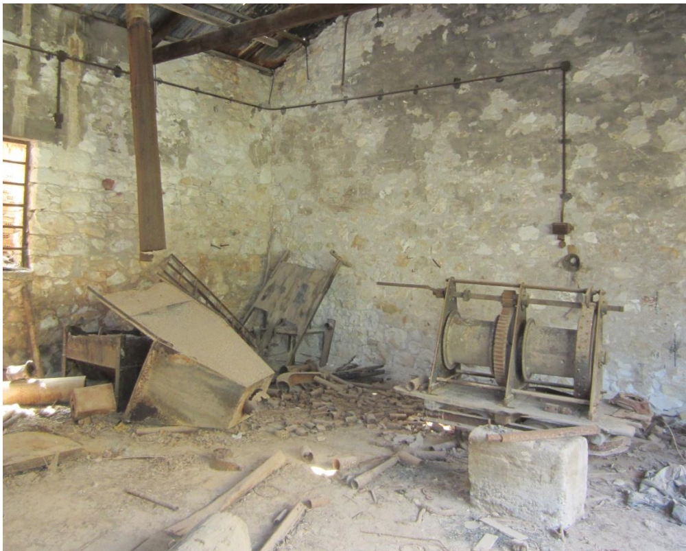
Εικόνα 35: Άποψη από το εσωτερικό του Μηχανουργείου, όπου σώζονται καμίνια για την επισκευή των μηχανών, φωτ. προσωπικό αρχείο γράφουσας.
