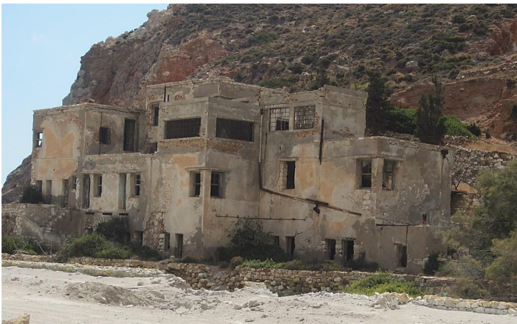
Εικόνα 32: Το κτίριο της διοίκησης στην νότια ενότητα του βιομηχανικού συγκροτήματος των Θειωρυχείων, φωτ. προσωπικό αρχείο γράφουσας.
