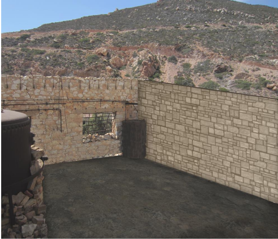
Σχέδιο 53: Σχηματική απεικόνιση αποκατάστασης της λιθοδομής του κτιρίου όπου στεγάζεται ο λέβητας παραγωγής ατμού με χρήση διακριτής δομής της νέας από την σωζόμενη τοιχοποιία.
