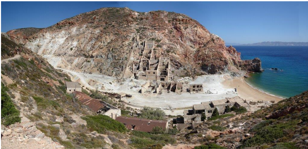
Εικόνα 23: Το κτιριακό συγκρότημα των Θειωρυχείων της Μήλου, στην απόληξη της δυσπρόσιτης πλαγιάς στην νοτιοανατολική πλευρά του νησιού, πηγή: edition.cnn.com .
