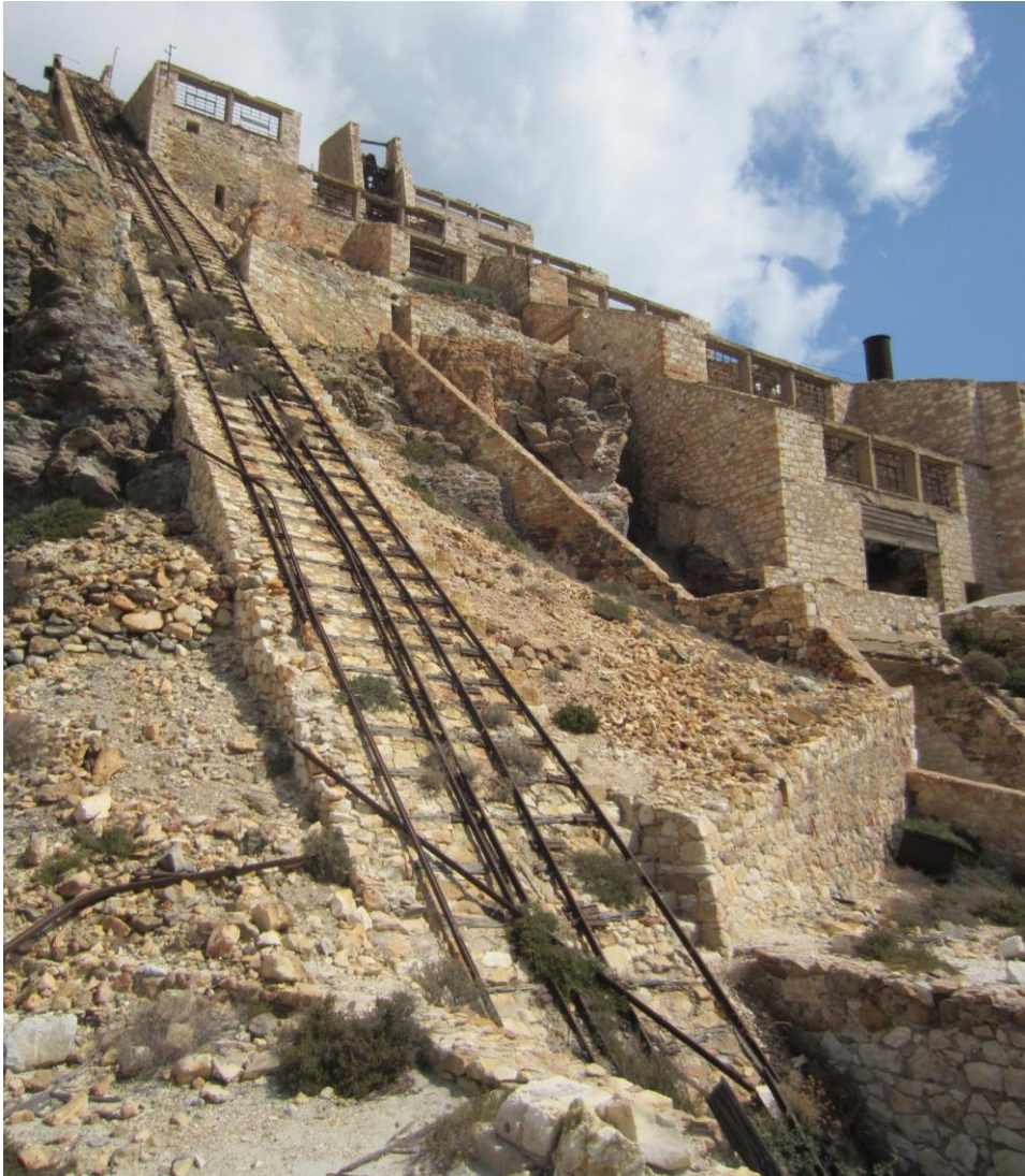
Εικόνα 44: Τοιχία αντιστήριξης ύψους έως και 18μ για τη συγκράτηση των χωμάτων, φωτ. προσωπικό αρχείο γράφουσας.
