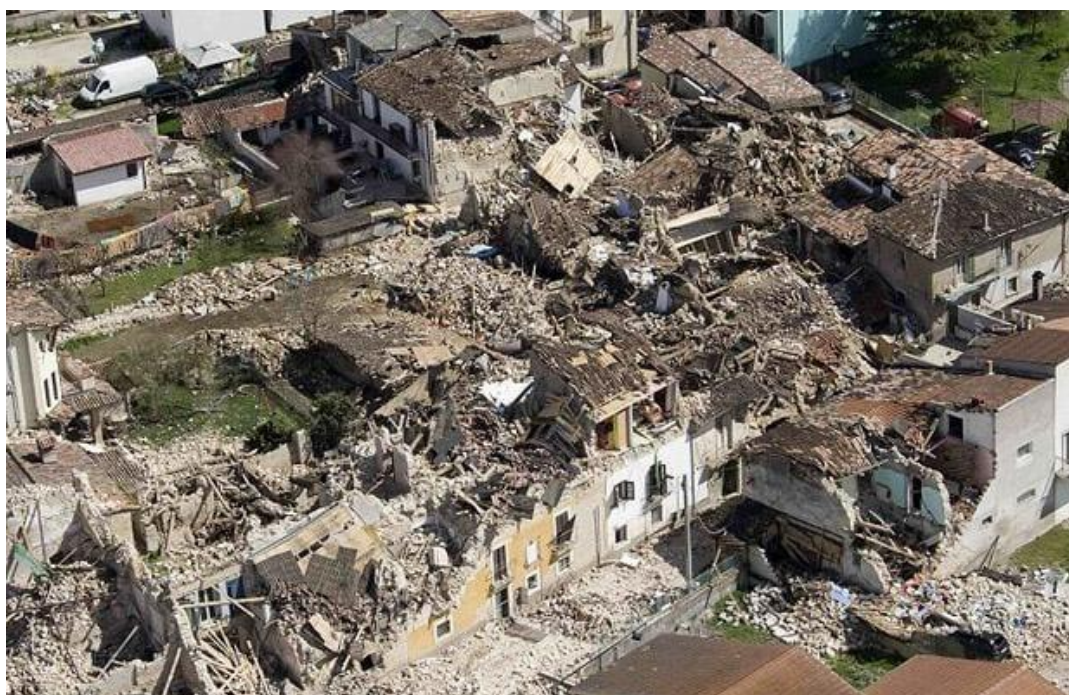
Εικόνα 3-5. Αεροφωτογραφία στη L'Aquila μετά το σεισμό.
