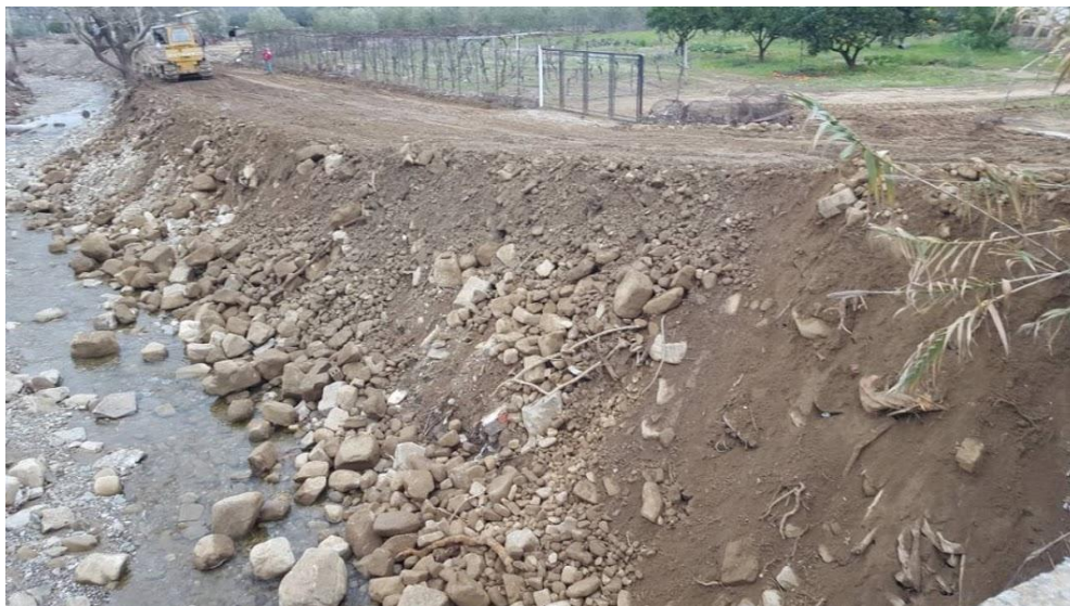
Εικόνα 6-10. Επιχωμάτωση πρανών δρόμου.
