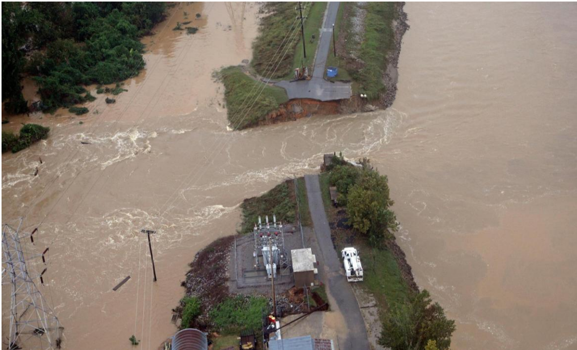
Εικόνα 1.2.3: Κατάρρευση φράγματος από πλημμυρικά ύδατα στην Νότια Κορέα (Λίμνη Άνω Ρόκφορντ) στις 5 Οκτωβρίου 2015 (πηγή: www.waterarchives.org ).
