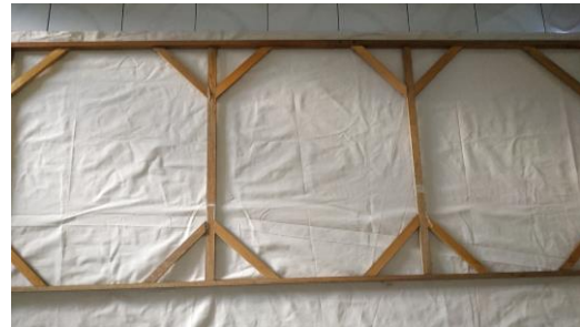
Gambar 6. Pemasangan kanvas (Sumber: Sultan, 2022)
