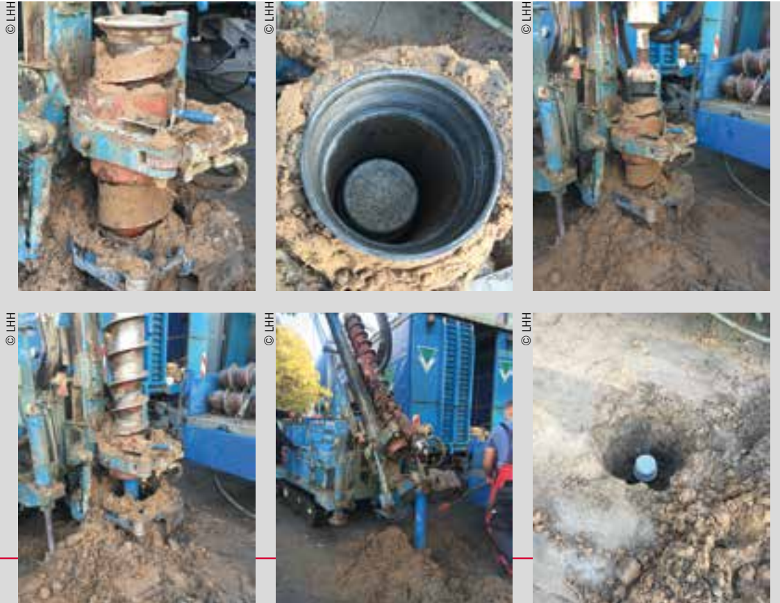
Bohrarbeiten zur Einrichtung einer Grundwassermessstelle
