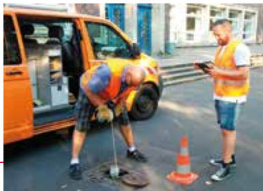
Messung des Grundwasserstandes mit Hilfe eines Lichtlotes
