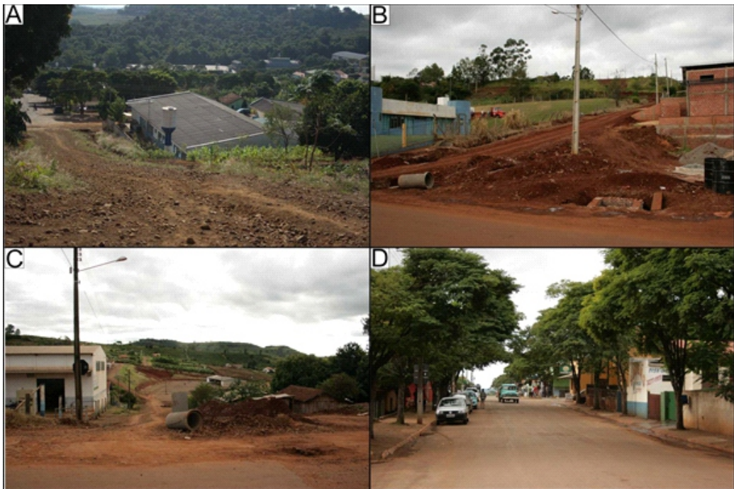
Figura 7: A – Rua sem pavimentação do alto do morro da Santa (Fotografia de Ana Paula Colavite - 2011); B e C – Obras de saneamento no percurso da via principal (Fotografia de Ana Paula Colavite - 2012); D – Rua Caramuru, PR 549, via principal da cidade de Corumbataí do Sul pavimentada, porém com baixo dinamismo e condições precárias de conservação (Fotografia de Ana Paula Colavite - 2012).
