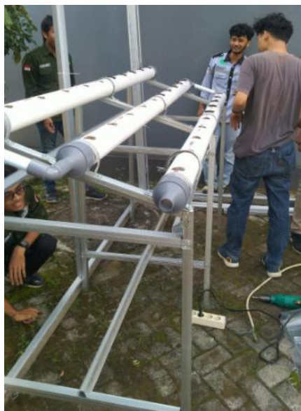
Gambar 6. Pembuatan Media Tanam Hidroponik Menggunakan Pipa Ukuran 3 Inch
