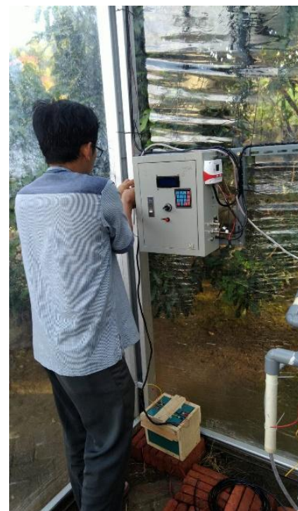
Gambar 10. Pemasangan Box Controller Hidroponik
