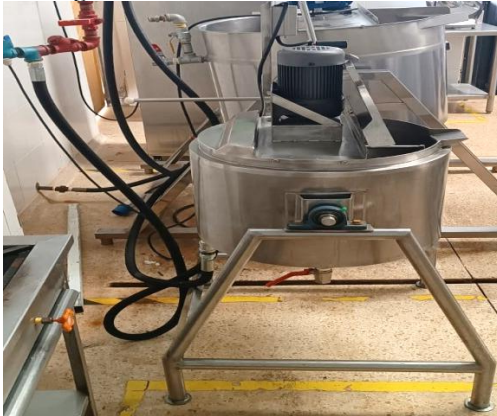
Imagen3. Instalacion de la marmita
