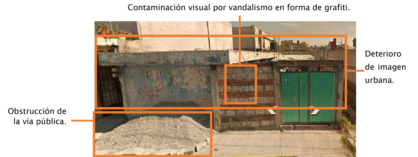
Ilustración 238; Viviendas en calle Vicente Guerrero, Perfil Sureste, Tramo B2 (2020)
