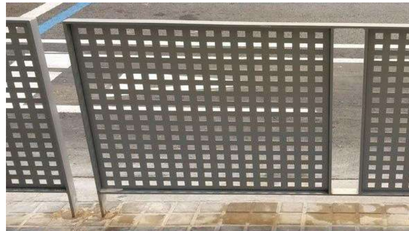
Ilustración 297: Valla de seguridad
