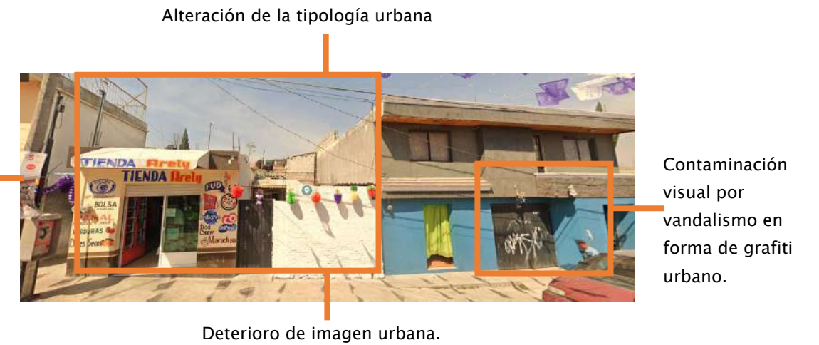
Ilustración 229: Local y vivienda en Av. Benito Juárez, Perfil Suroeste, Tramo B2 (2020)
