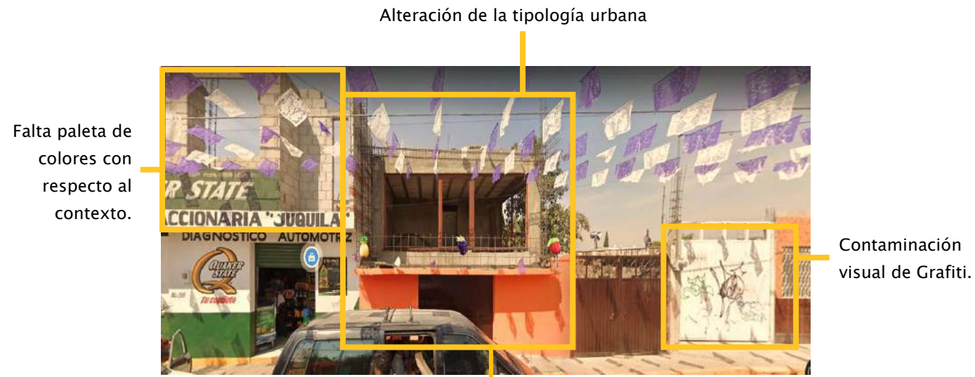
Ilustración 228: Local y vivienda en Av. Benito Juárez, Perfil Suroeste, Tramo B1 (2020)
