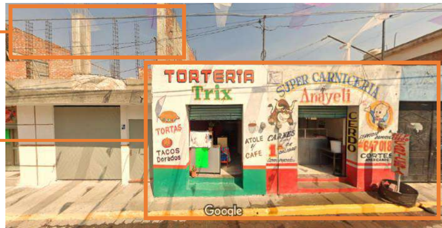
Ilustración 218: Vivienda y locales comerciales en calle Morelos Norte/ Perfil noroeste, Tramo A2 (2020)
