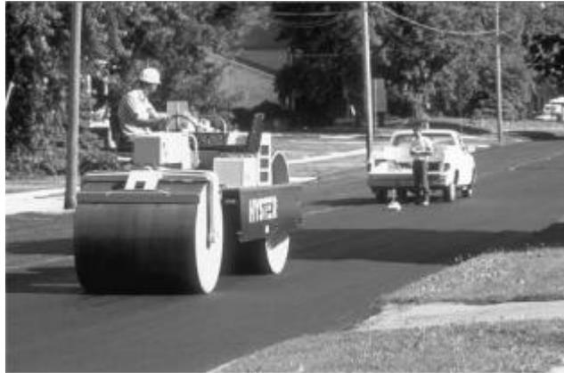
Figura 11 Proceso de compactación usando rodillo compactador estático
