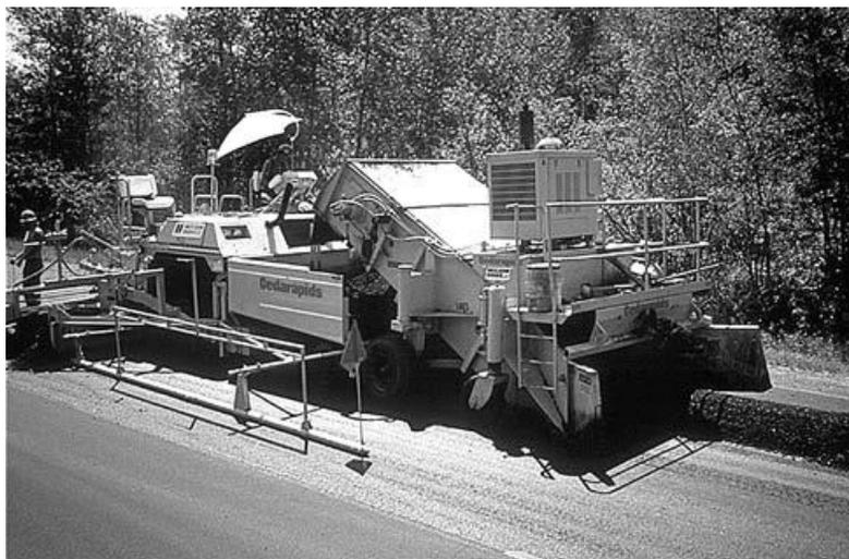
Figura 17 Extendido de mezcla asfáltica
