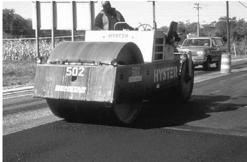
Figura 18 Compactación de mezcla asfáltica
