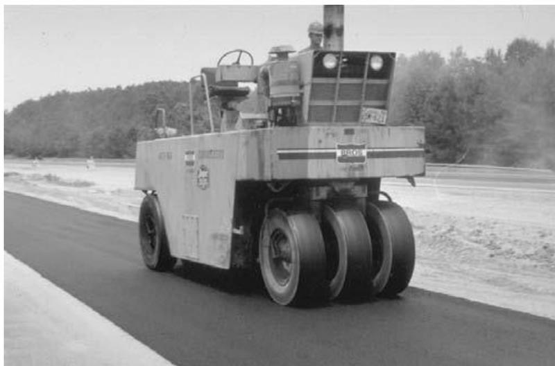
Figura 12 Compactación estática con rodillos neumáticos
