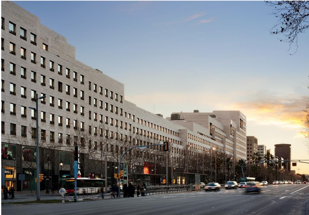
Figura 23. Vista Peatonal de la Galería Comercial de L'illa Diagonal. Fuente: Rafael Moneo (s/f)
