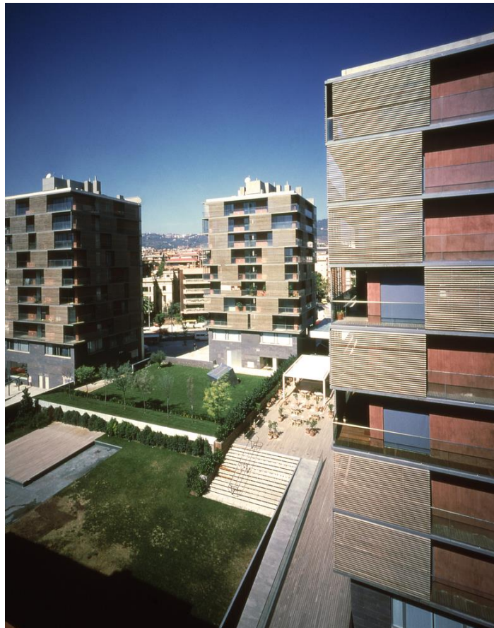
Figura 27. Complejo Híbrido Illa Fleming con Espacio Colectivo Integrado. Fuente: Bach Arquitectes (1999)
